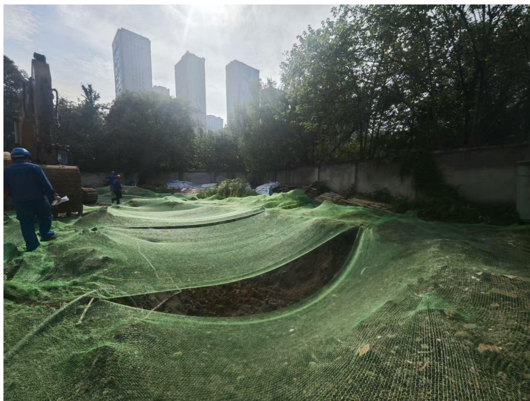
施工过程中土袋与密目网措施
