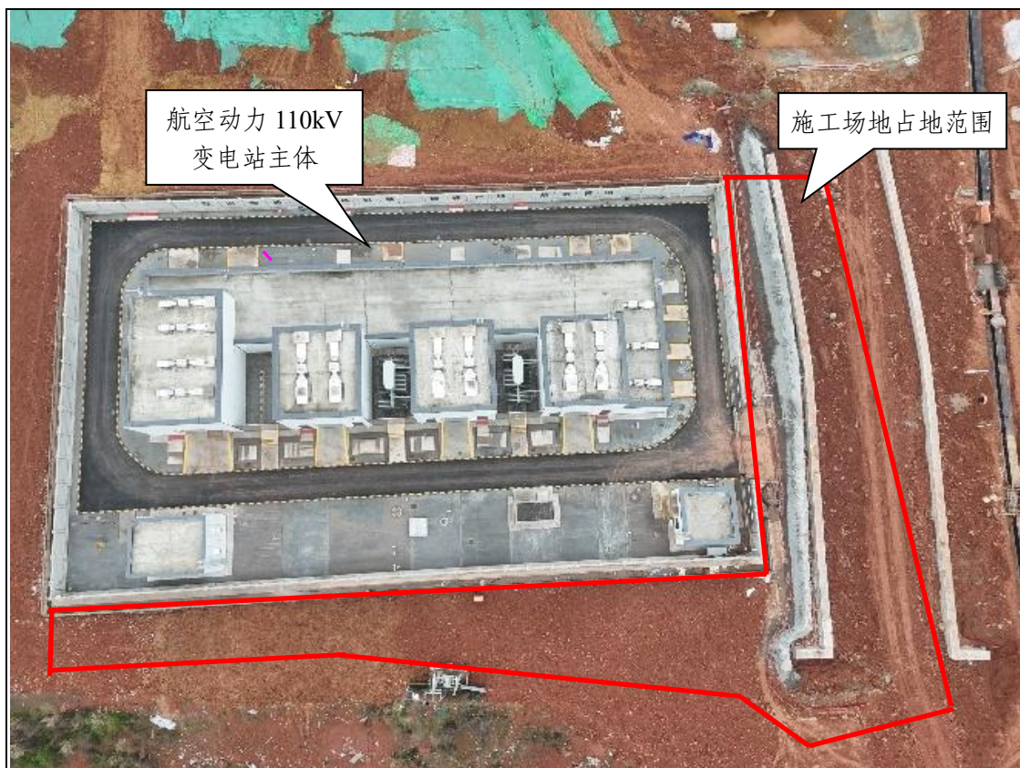
航空动力 110kV 变电站现状
