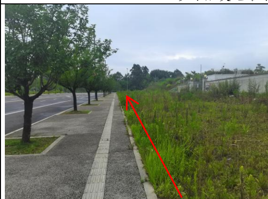
科智-航空动力 110kV 线路工程沿线现状 1
