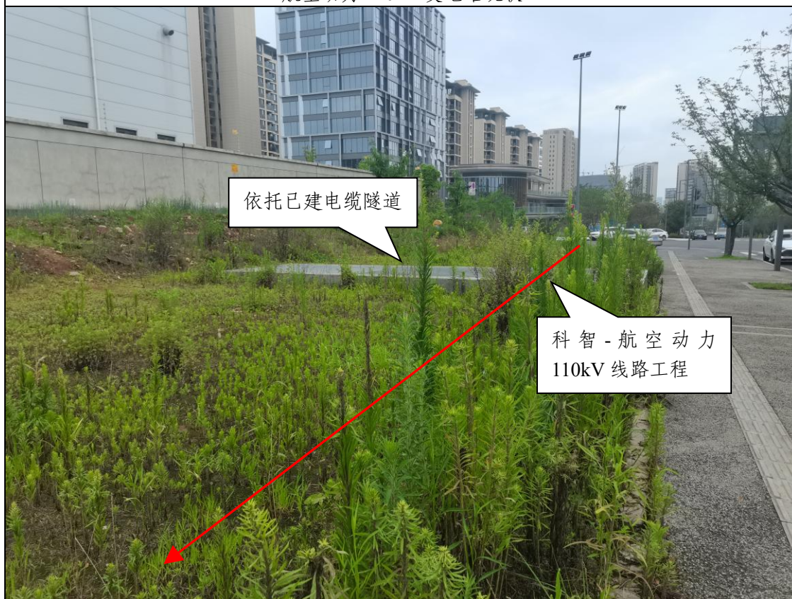
科智 220kV 变电站北侧既有电缆隧道
