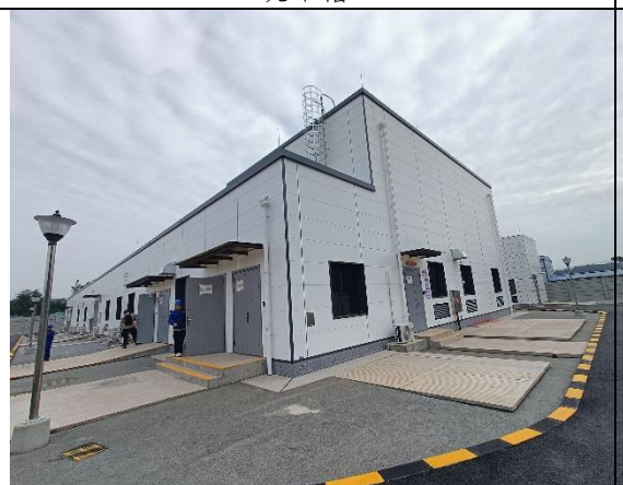
透水混凝土地坪
