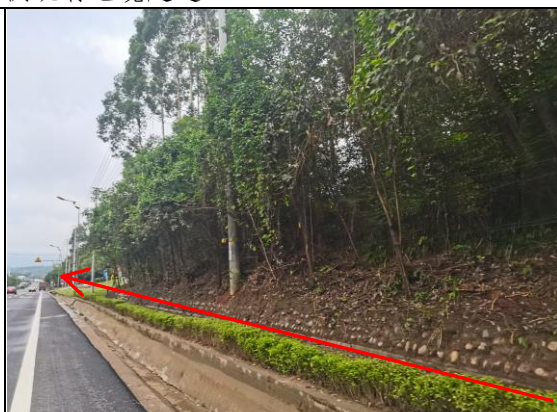
科智-航空动力 110kV 线路工程沿线现状 2
