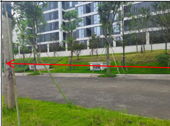
罗家店-航空动力 110kV 线路工程沿线现状 2
