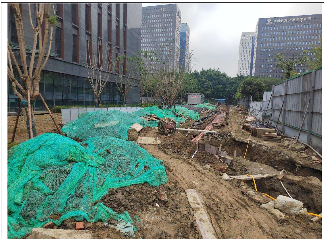
主体工程区临时遮盖（2024.10）
