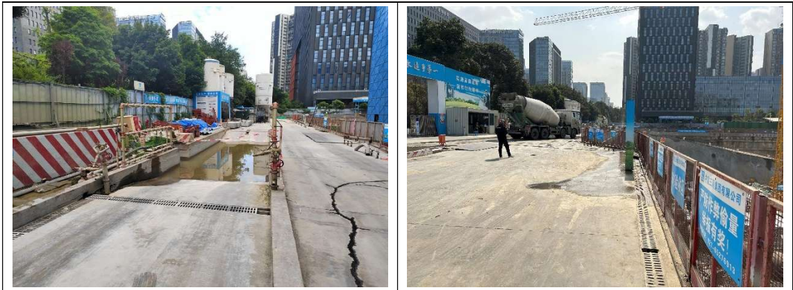
主体工程区车辆冲洗设施、坑顶截水沟（2023.4）
