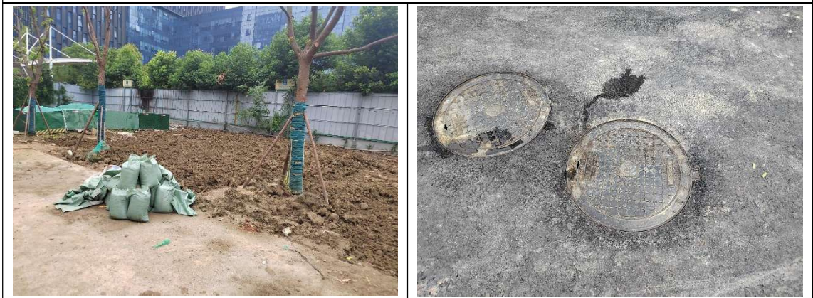
主体工程区表土回覆、雨水井（2024.10）
