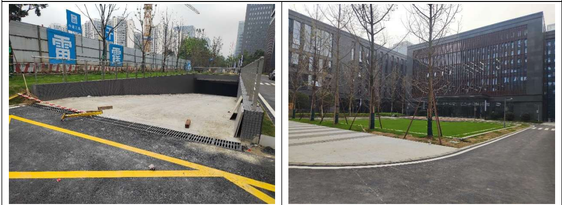
主体工程区车库出入口排水沟、景观绿化（2024.10）
