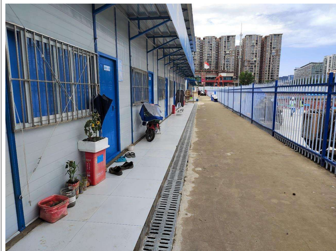
施工生产生活区临时排水沟（2023.1）
