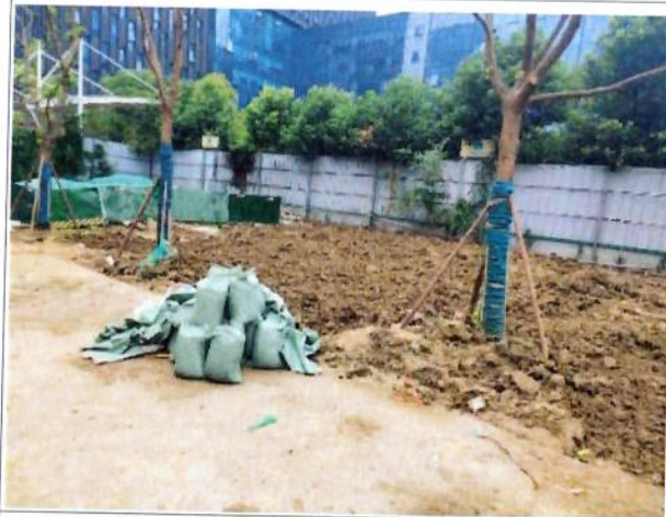
场地内表土回覆
