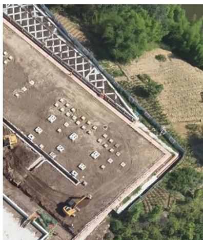
变电站站区护坡、排水沟、站内设施基础（建设中）
