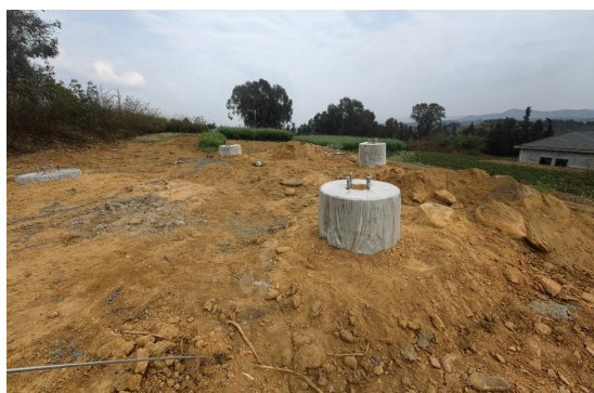
琵琶（古佛）—黄市 220kV 线路工程 N39 塔位
