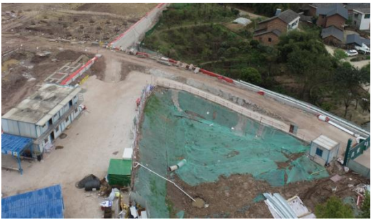
施工场地临时遮盖
