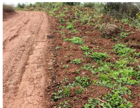
王渡—黄市 220kV 线路工程 N20 塔位施工便道 剥离表土堆存于道路一侧
