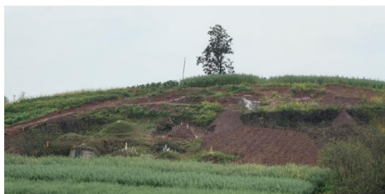
王渡—黄市 220kV 线路工程 N21 塔位及施工道路
