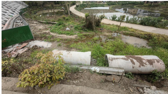
变电站站区排水管（外排接口尚未完成）
