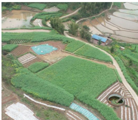
王渡—黄市 220kV 线路工程 N22 塔位及施工道 路
