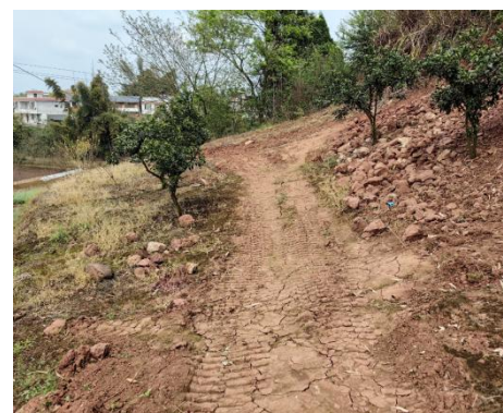
琵琶（古佛）—黄市 220kV 线路工程 N13 塔位 施工道路
