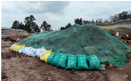
站内临时堆土拦挡和遮盖
