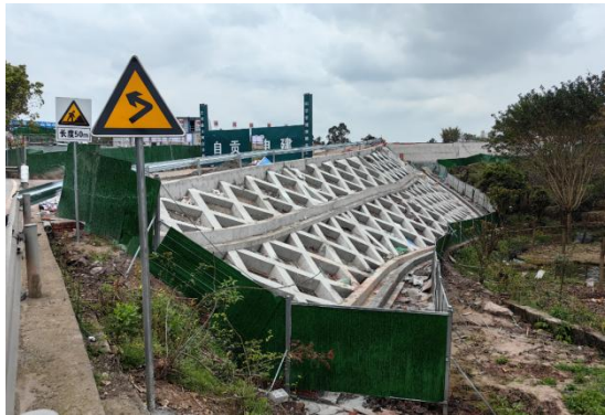
变电站站区护坡、排水沟（建设中）
