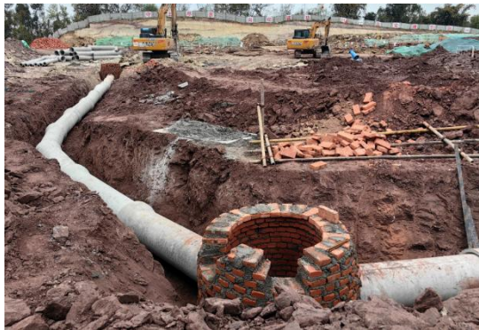
站内雨水管网施工
