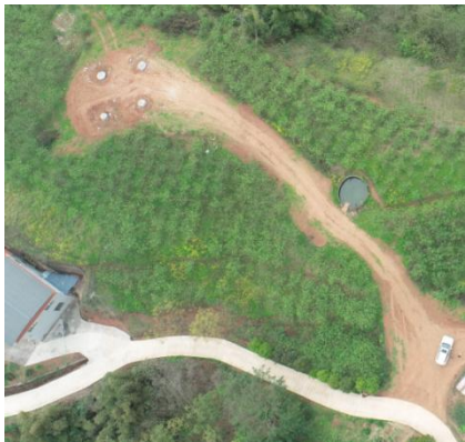
琵琶（古佛）—黄市 220kV 线路工程 N9 塔位 及施工道路
