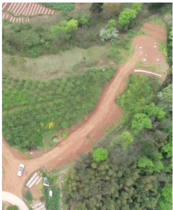
琵琶（古佛）—黄市 220kV 线路工程 N10 塔位 及施工道路
