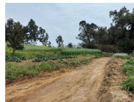
琵琶（古佛）—黄市 220kV 线路工程 N39 塔位 施工道路剥离表土堆存于道路一侧
