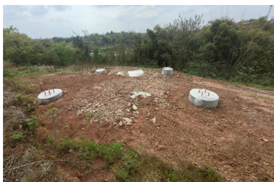
琵琶（古佛）—黄市 220kV 线路工程 N13 塔位
