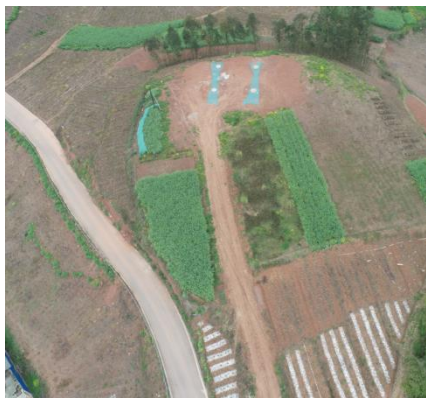
王渡—黄市 220kV 线路工程 N23 塔位及施工道 路
