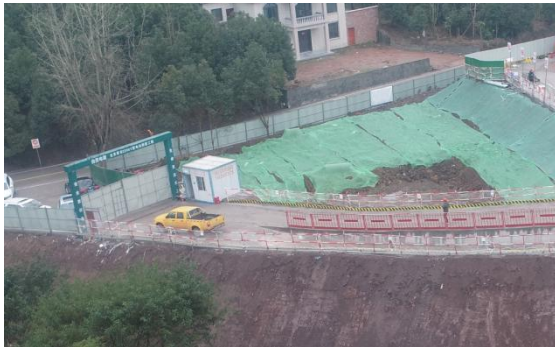
施工场地临时遮盖
