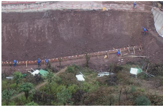
变电站站区排水沟（建设中）
