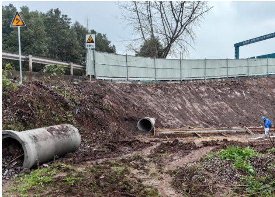
变电站站区排水管（外排接口尚未完成）
