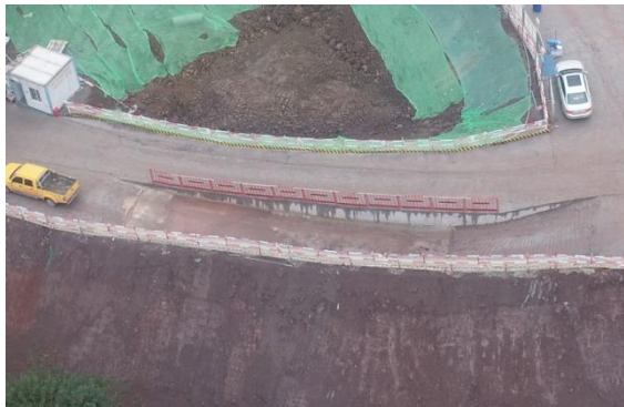
施工入口洗车槽
