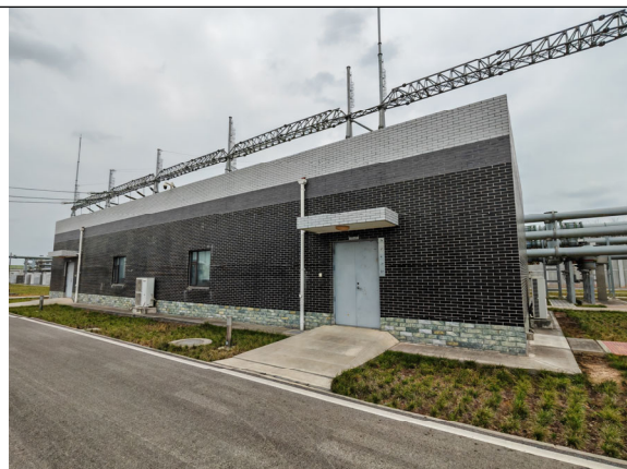
500kV 及主变继电器室
