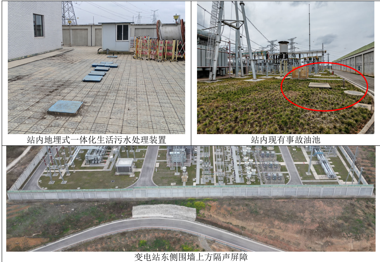
图 3-2 绵州 500kV 变电站内现有设施照片
