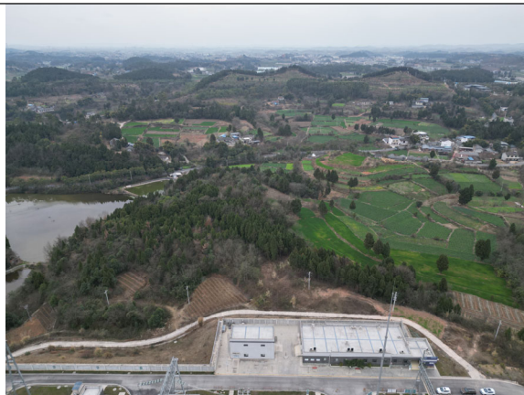
绵州 500kV 变电站西侧围墙外环境
