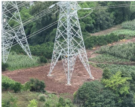
N3 塔基及施工便道，余土在塔基摊铺，已实施土地整治
