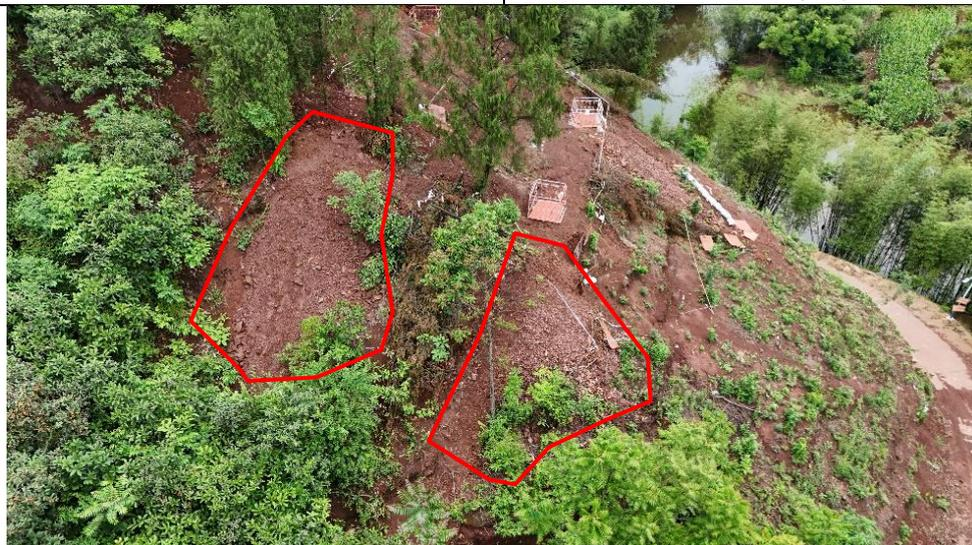
A6 塔位堆放的土石方无挡护和遮盖措施，存在顺坡溜渣
