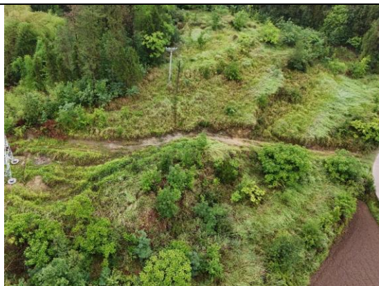
N22 塔施工临时道路植被恢复情况
