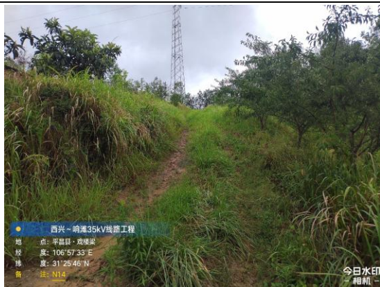
N14 塔施工临时道路植被恢复情况
