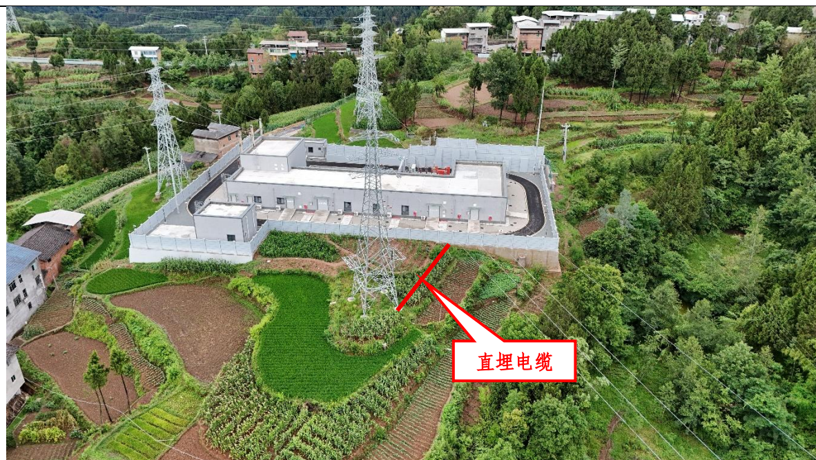
西兴 110kV 变电站侧电缆复耕情况
