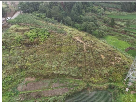
N18 塔施工临时道路植被恢复情况
