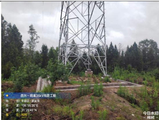
N28 塔砼排水沟、植被恢复情况
