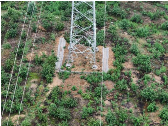
N27 塔砼排水沟、植被恢复情况
