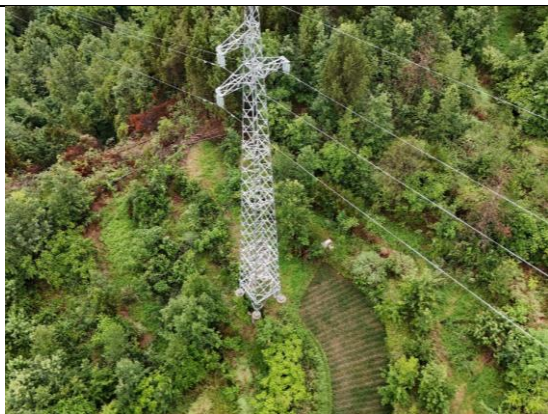
N12塔复耕、植被恢复情况
