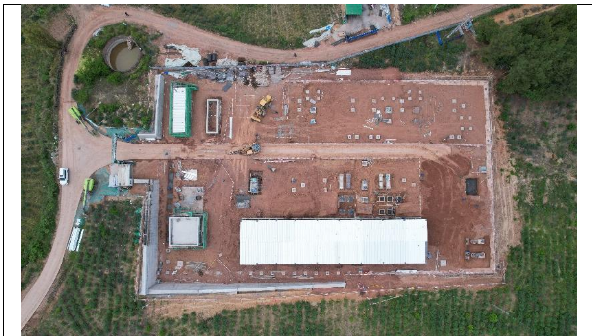
站区闲置裸露地表采取的苫盖范围不足，周边缺乏临时排水、沉沙措施
