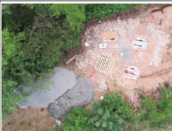
永安一岭上 N42 塔未开展表土剥离及堆存保护，临时苫盖措施不足，土石方堆放散乱
