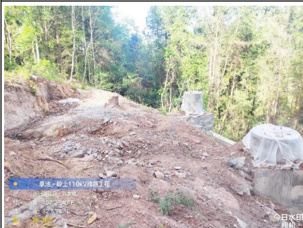
草池—岭上 N87 塔基础开挖前未开展表土剥离及堆存保护
