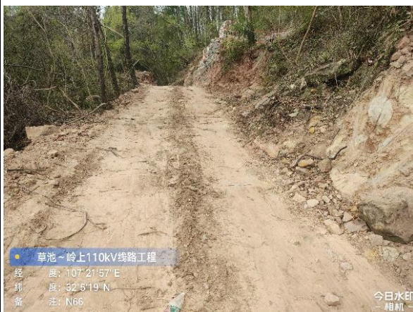
草池—岭上 N66 塔汽运道路未合理开展表土剥离及堆存保护，挖填坡面未及时采取苫盖措施，未及时采取临时排水、沉沙措施
