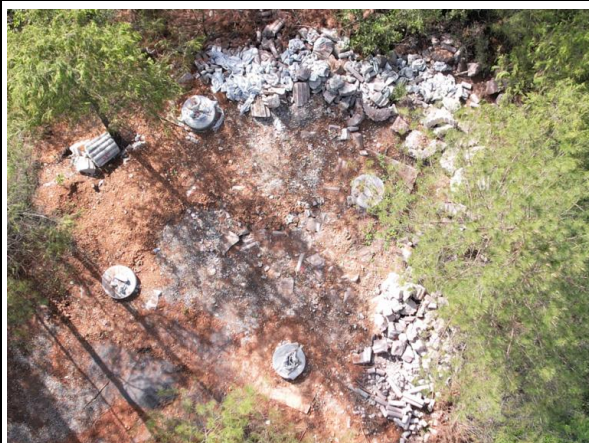
永安一岭上 N35 塔未开展表土剥离及堆存保护，土石方堆放散乱
