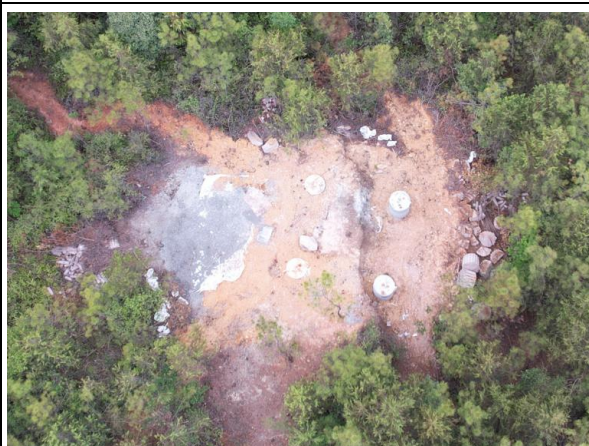
永安一岭上 N40 塔未开展表土剥离及堆存保护，临时苫盖措施不足，土石方堆放散乱
