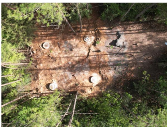
永安一岭上 N36 塔未开展表土剥离及堆存保护，临时苫盖措施不足，土石方堆放散乱
