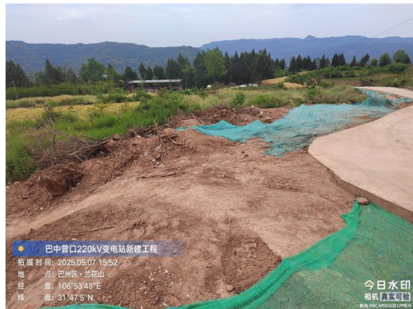
施工空闲区域、材料堆放、进站道路临时遮盖
