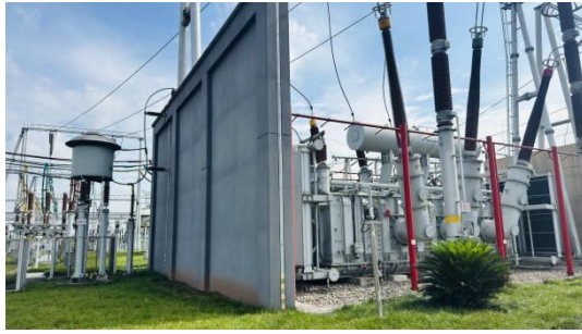
既有主变间防火墙（3 号主变）
