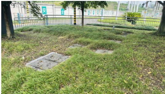
生活污水处理设施
