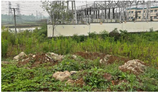
西侧扩建新增占地现状照片
