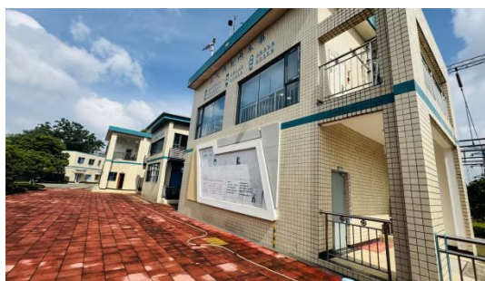
主控通信综合楼
