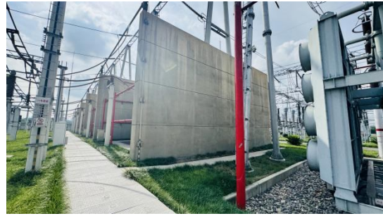
既有主变间防火墙（1 号和 2 号主变）
