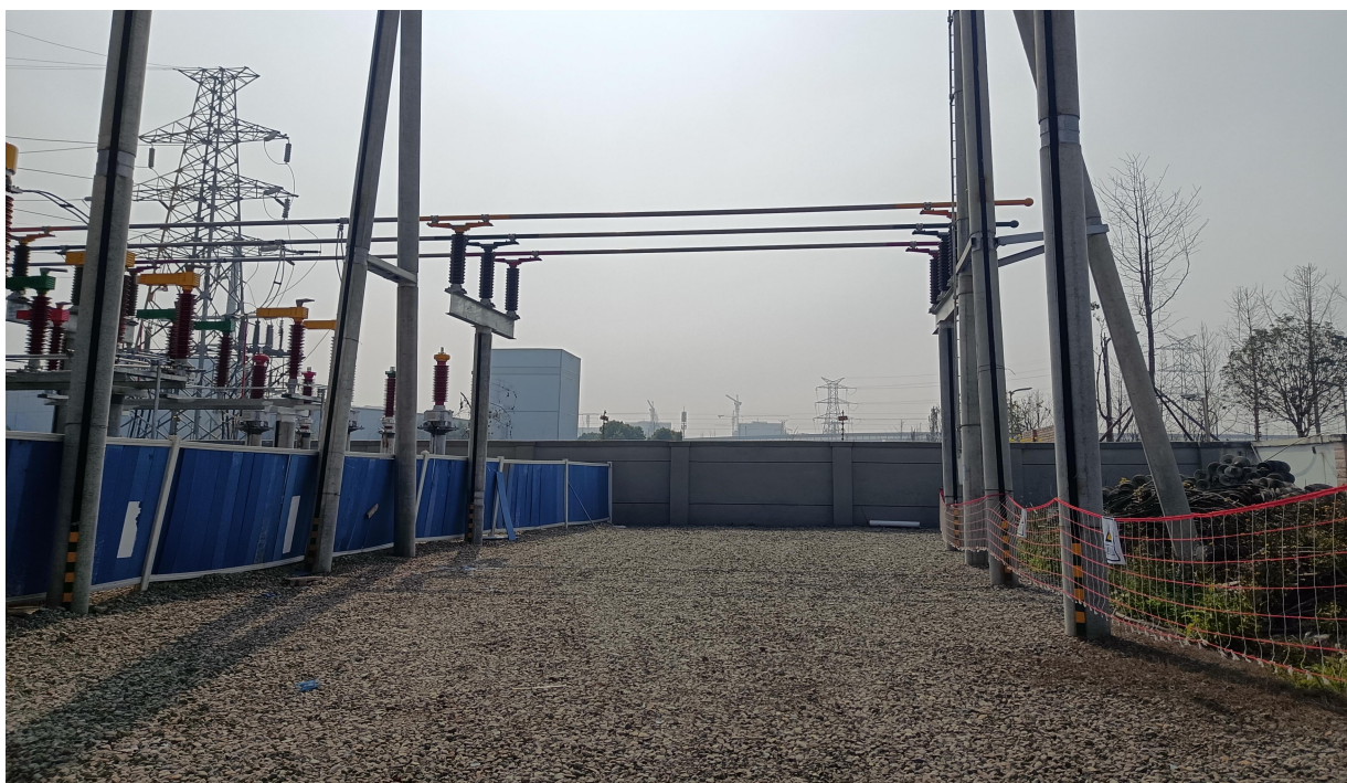
图 2.1-2 武侯 220kV 变电站 110kV 预留间隔现状
