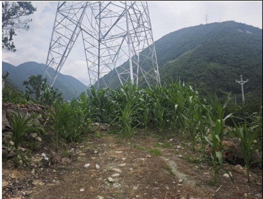
N111 施工道路现状
