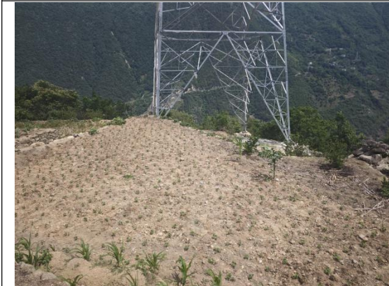
N107 施工道路现状
