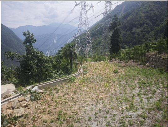
N106 施工道路现状
