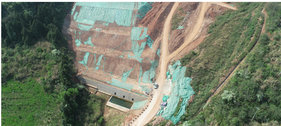
图 3.2-1 接纳场地现状（成渝中线铁路项目渣场）
