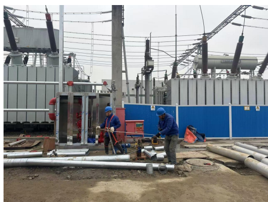
施工期雨水管安装
