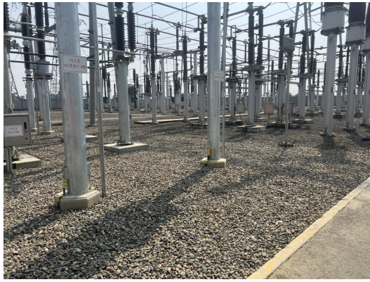
220kV 配电装置扩建区碎石干铺 2
