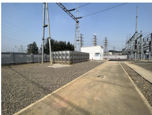
新建消防水池及泵房
