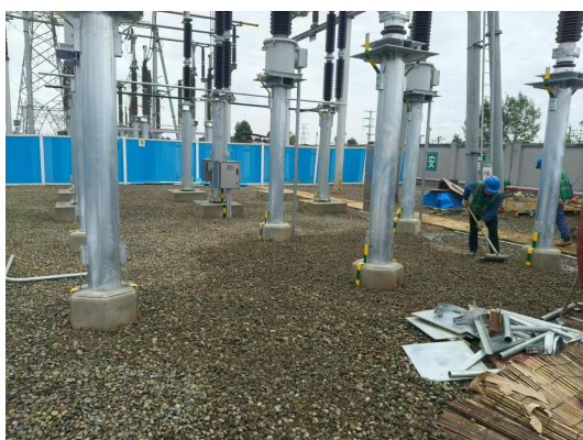
施工期变电站扩建区碎石干铺
