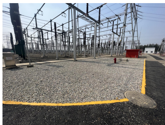
新建事故油池及碎石干铺
