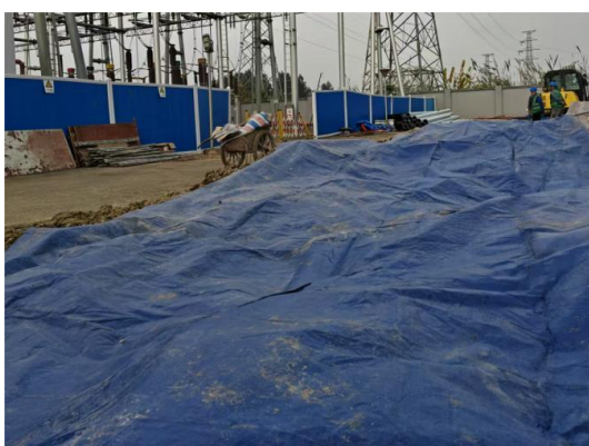
施工期变电站扩建区防雨布遮盖
