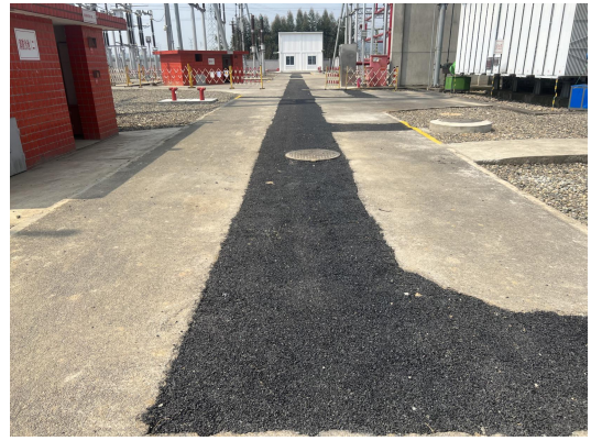
雨水管安装区域
