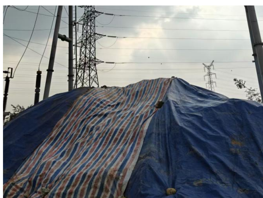
施工期临时堆土防雨布遮盖
