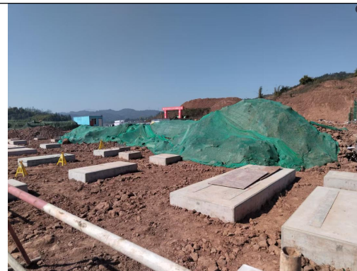
变电站施工现状
