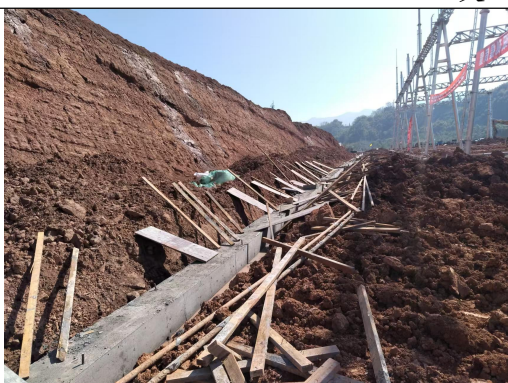
变电站施工现状
