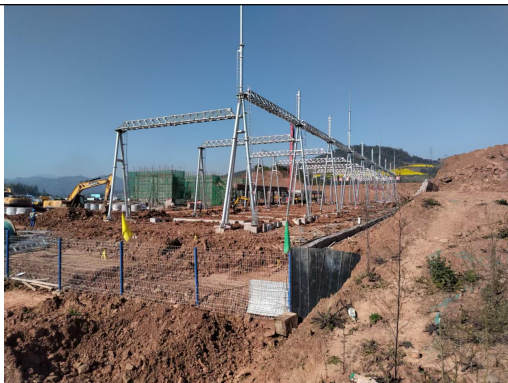
变电站施工现状
