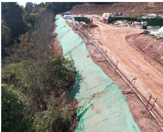
坡面临时遮盖
