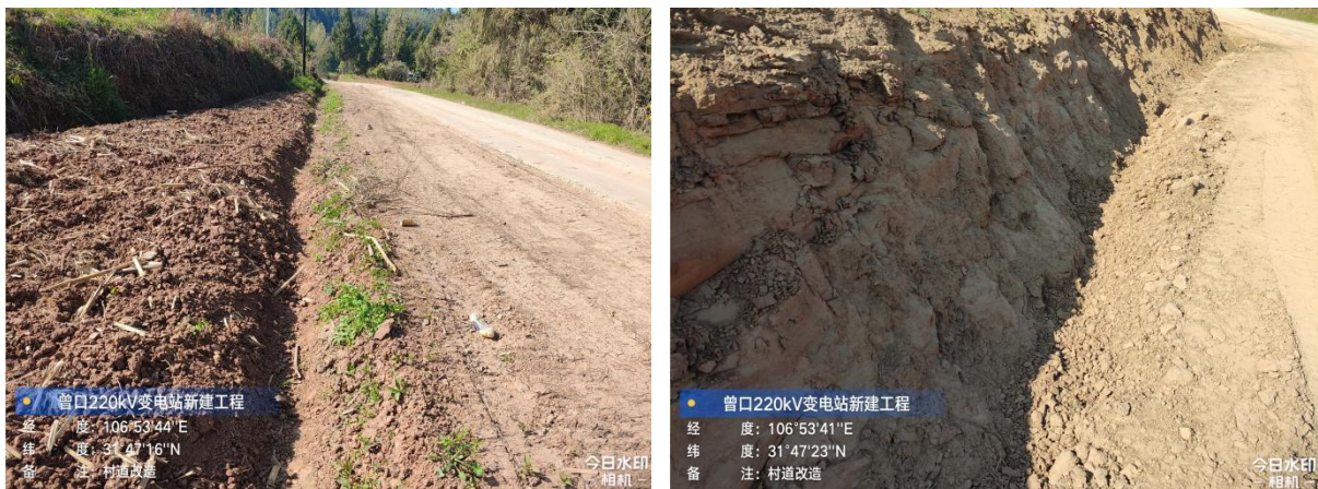
村道拓宽内侧临时排水沟
