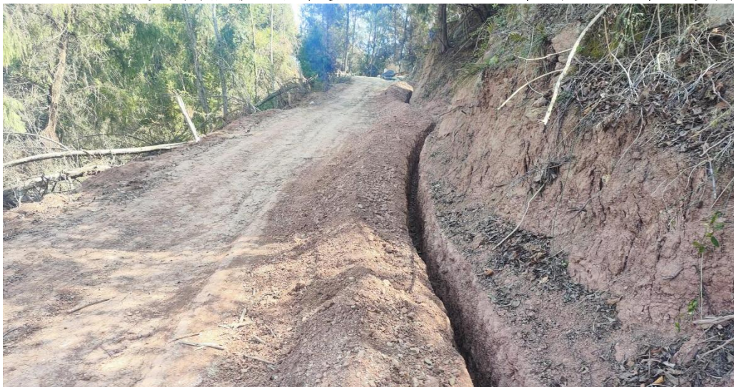
巴中~曾口 II 回 N20 汽运道路临时排水沟
