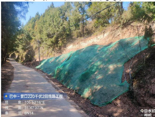
巴中~曾口 II 回 N14 汽运道路填方坡面临时遮盖
