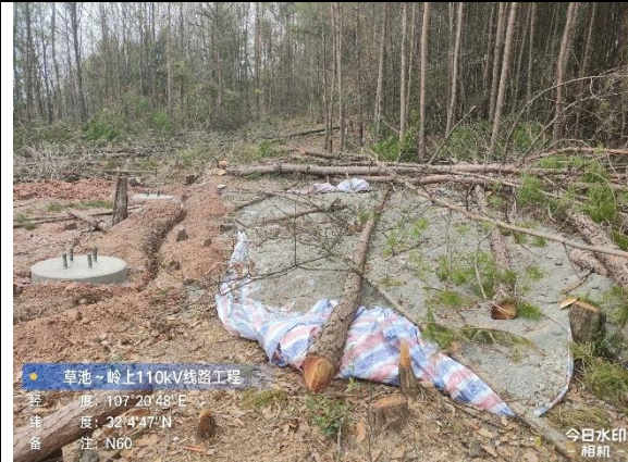
草池~岭上 N60 塔临时铺垫
