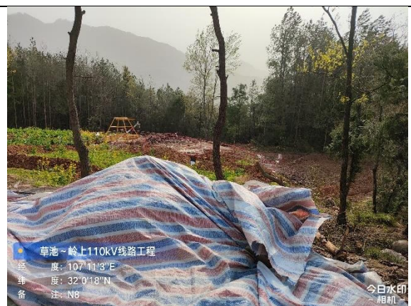
草池~岭上 N7 塔临时苫盖
