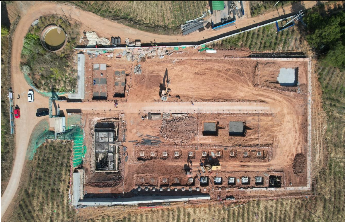
岭上 110kV 变电站施工情况
