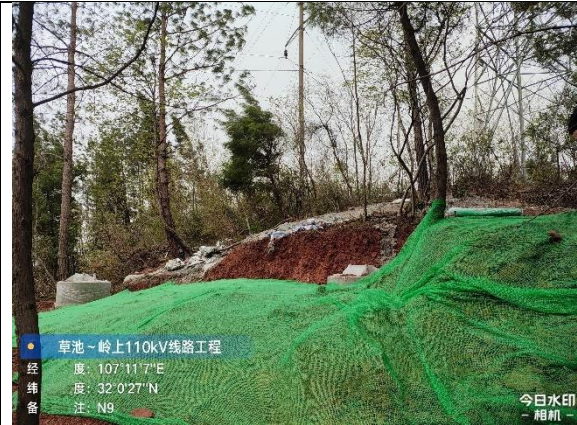
草池~岭上 N9 塔临时苫盖、铺垫
