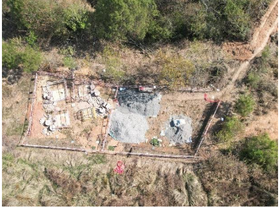
草池~岭上 N94 塔临时铺垫
