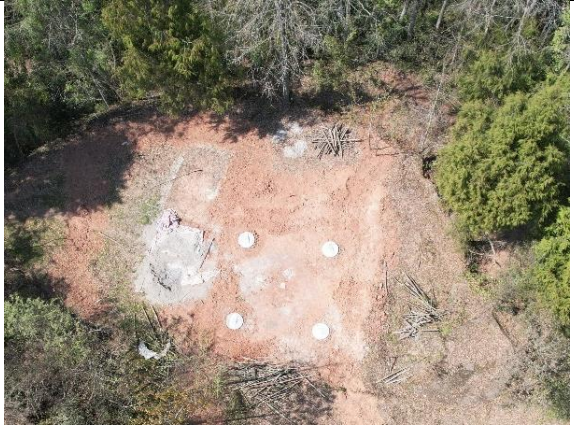
草池~岭上 N85 塔表土回覆、土地整治、临时铺垫
