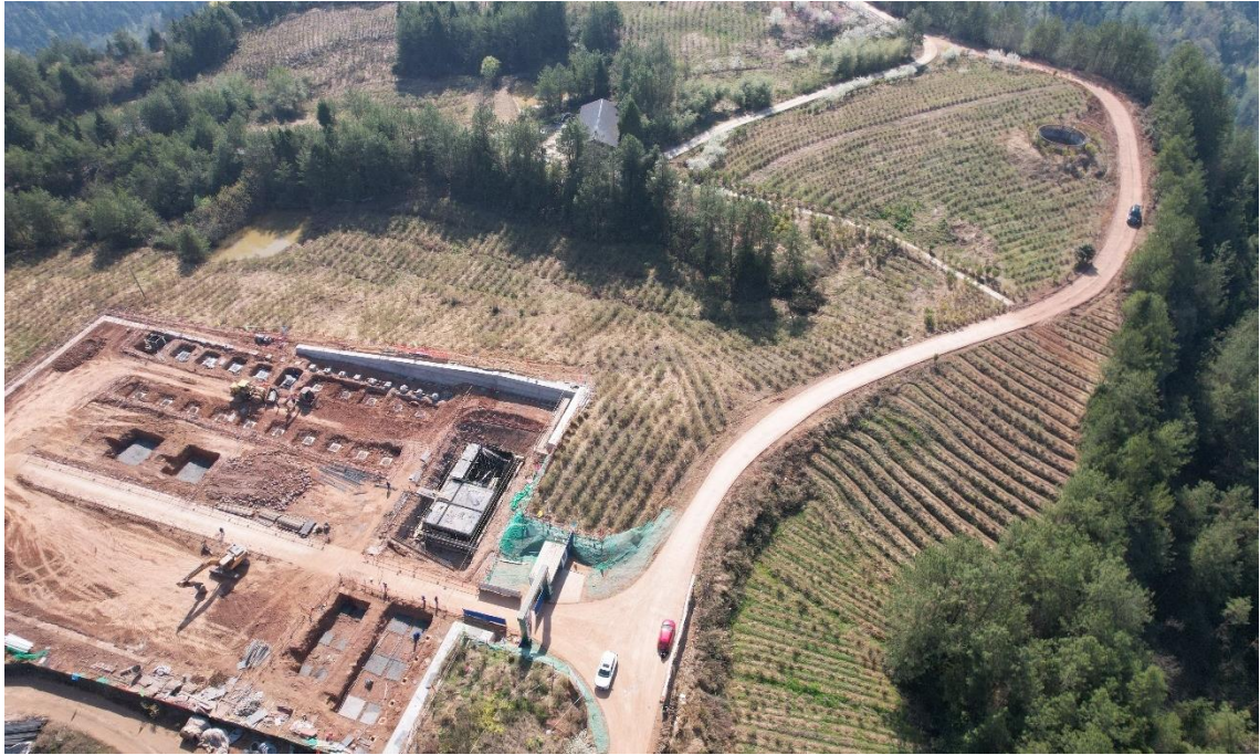
岭上 110kV 变电站引接道路现状
