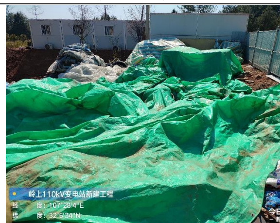
堆料临时苫盖
