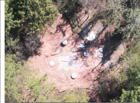
草池~岭上 N82 塔表土回覆、土地整治
