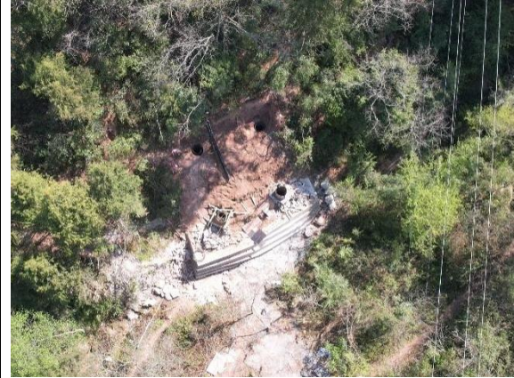
草池~岭上 N86 塔挡土墙
