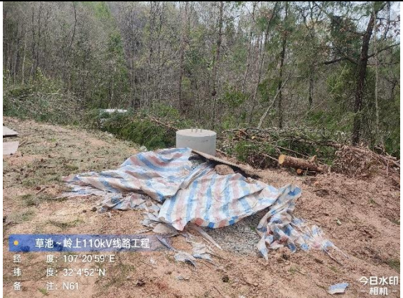
草池~岭上 N61 塔临时苫盖、铺垫
