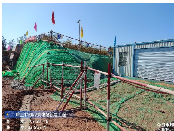
开挖坡面临时苫盖
