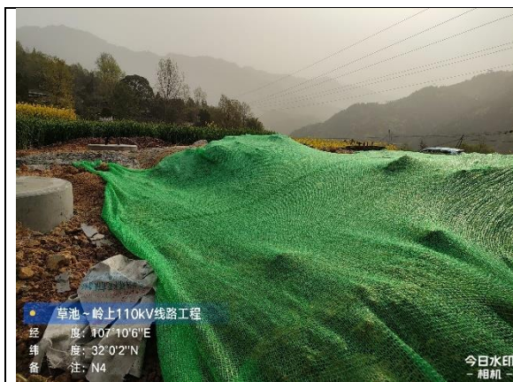
草池~岭上 N4 塔临时苫盖
