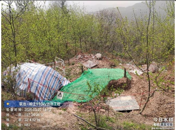
草池~岭上 N57 塔临时苫盖
