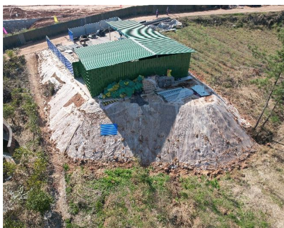
钢筋、木工加工场
