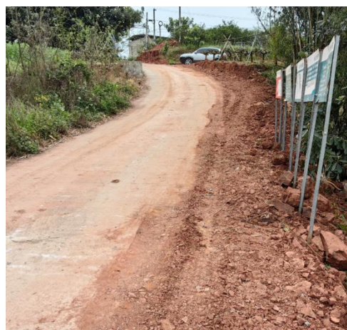
N41 塔位施工便道拓宽
