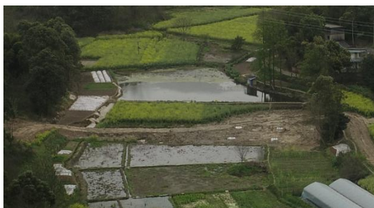
NC1 塔位及施工便道
