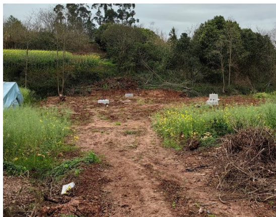
N39 塔基及施工便道，余土在塔基摊铺
