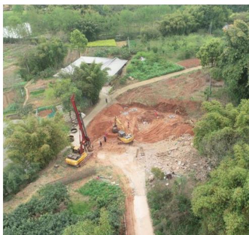
N41 塔位施工
