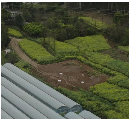
N44 塔基及施工便道
