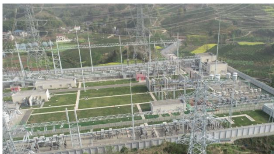
变电站间隔扩建工程—尚未开工
