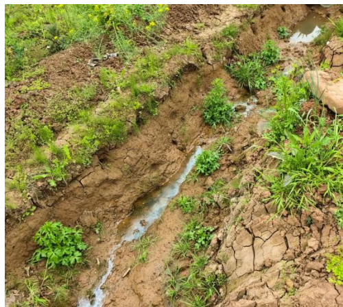
N39 塔基施工便道临时排水沟
