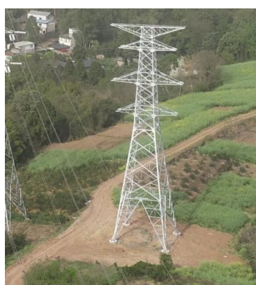
N3 塔基及施工便道, 余土在塔基摊铺
