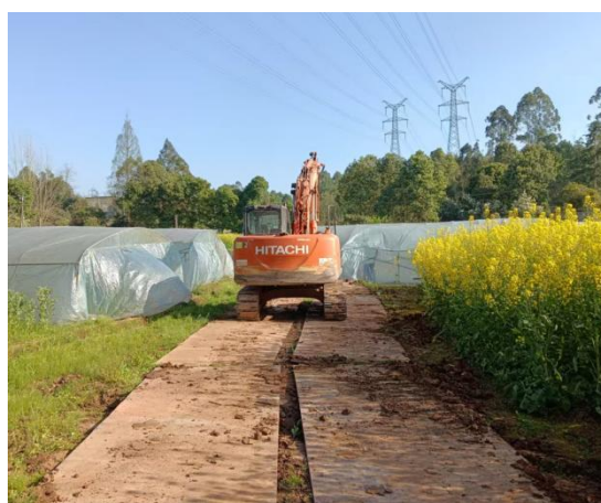
N44 塔位施工便道钢板铺设
