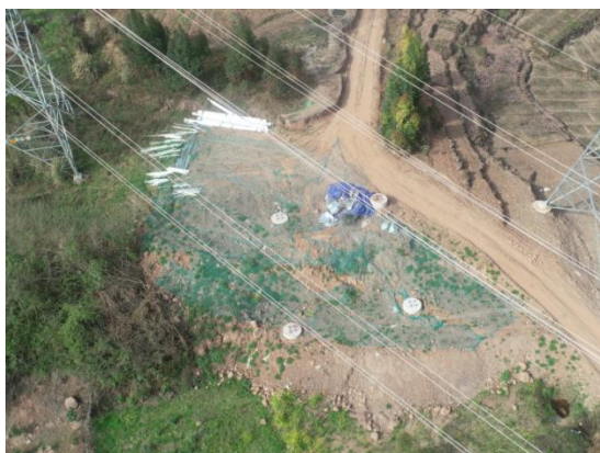
NB1 塔基基面临时遮盖
