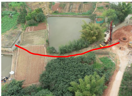
电缆工程区--尚未施工
