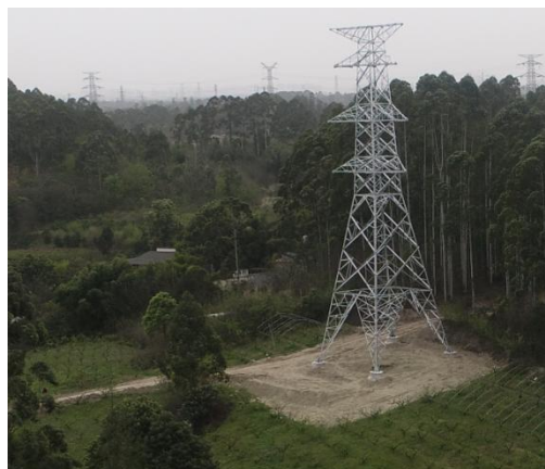
N43 塔位及施工便道
