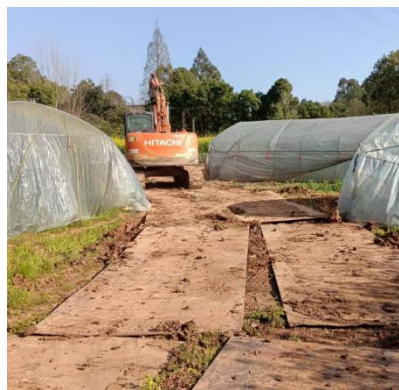
NC1 塔位施工便道钢板铺设
