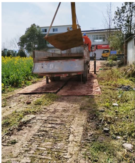
N40 塔基施工便道铺垫钢板保护
