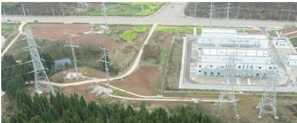
电缆工程施工作业带
