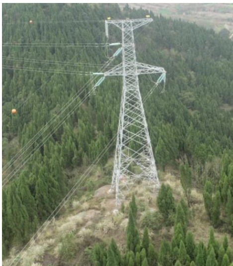
NA19 塔位及人抬道路
