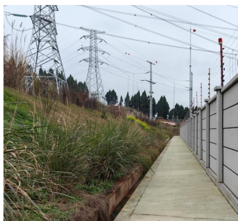
变电站站区排水沟和边坡绿化
