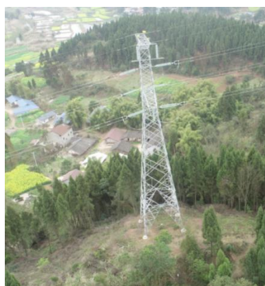
NA18 塔位及人抬道路
