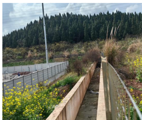
变电站站区截水沟和边坡绿化
