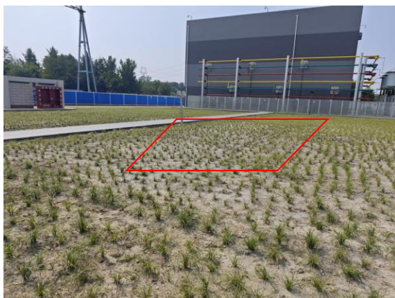
图片 4-1 变电站扩建区域现状
