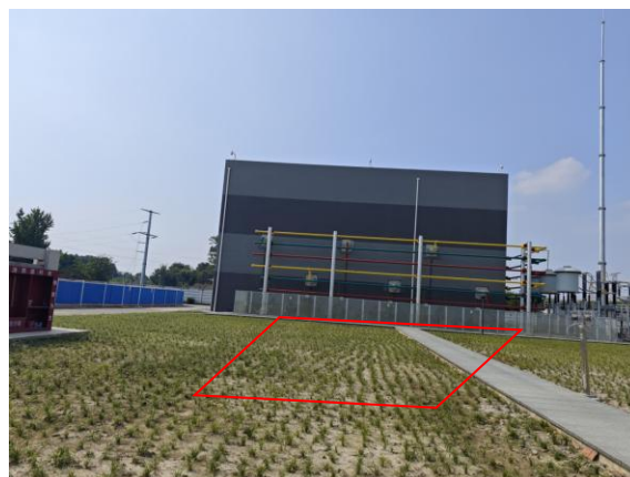
图片 4-2 变电站扩建区域现状
