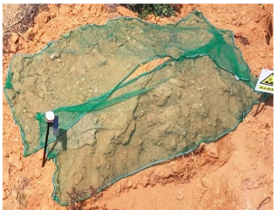
图8-6 塔基区开挖堆土密目网苫盖
