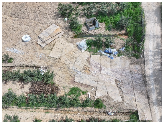
图8-1 塔基区钢板铺设
