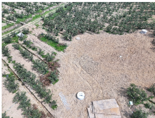
图8-2塔基区施工完成后进行场地整治
