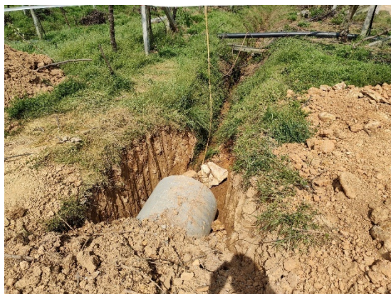
图8-3 塔基区自然冲沟采用排水管疏通
