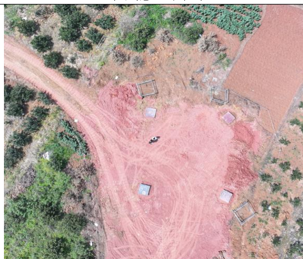
塔基及施工场地区
