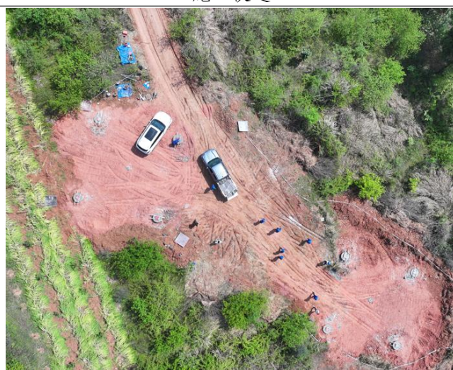
塔基及施工场地区
