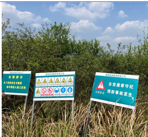
塔基施工公示牌
