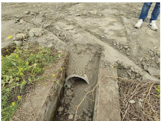
图8-3 塔基区自然冲沟采用排水管疏通
