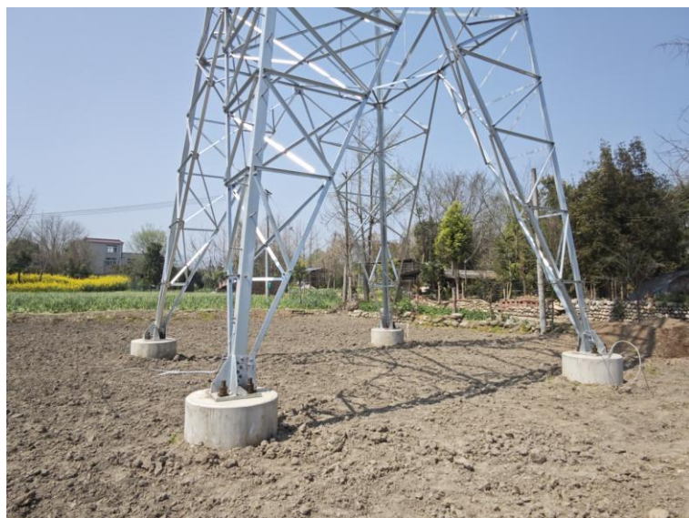
图 4.3-15 N54 已组塔塔基，永久占地区域土地整治差，未进行撒播草籽
