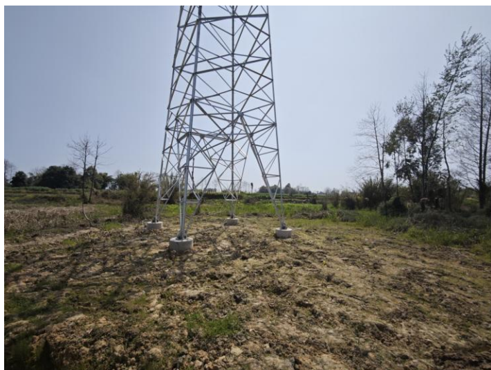
图 4.3-16 N66 已组塔塔基，永久占地及施工临时占地区域土地整治差，未进行撒播草籽
