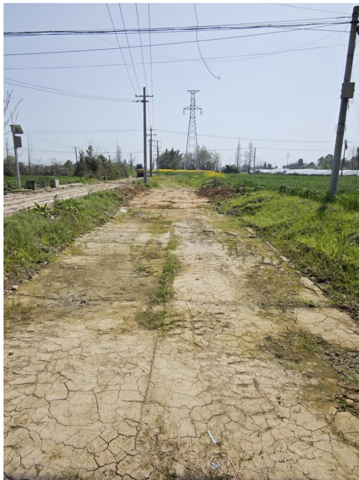
图 4.3-8 N59 施工道路，施工道路使用结束后未进行土地整治，恢复耕地
