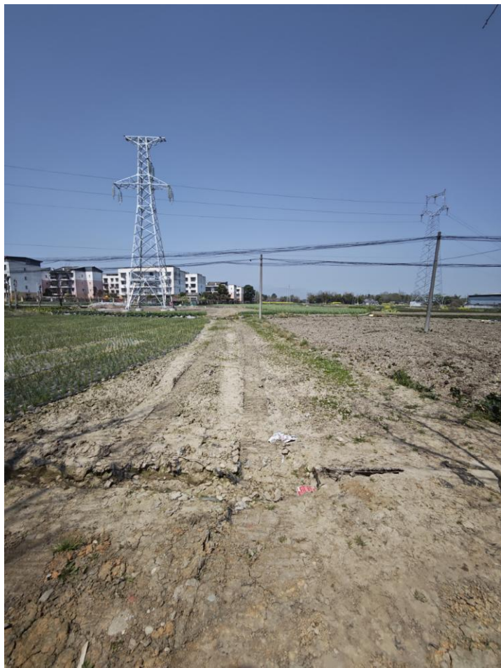
图 4.3-7 N51 施工道路，施工道路使用结束后未进行土地整治，恢复耕地
