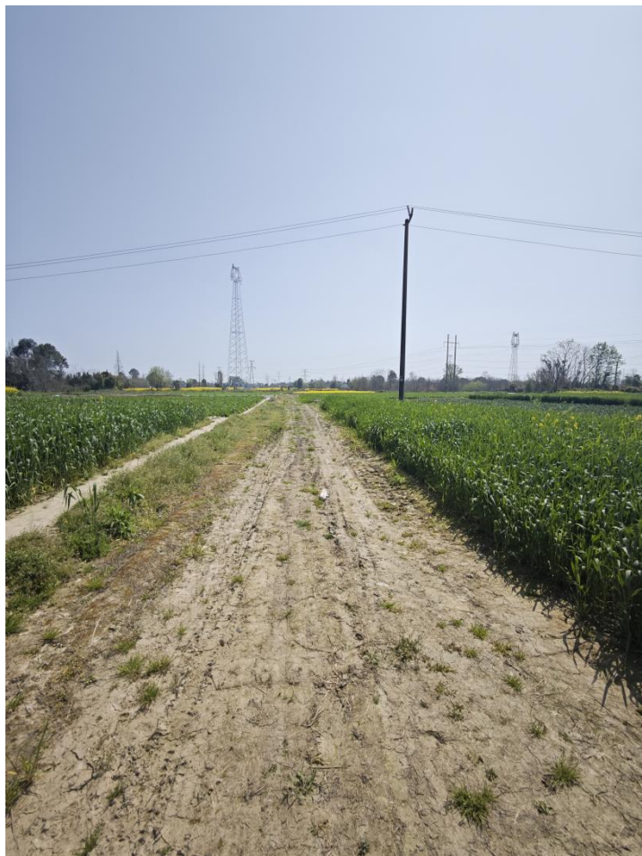
图 4.3-5 N27 施工道路，施工道路使用结束后未进行土地整治， 恢复耕地
