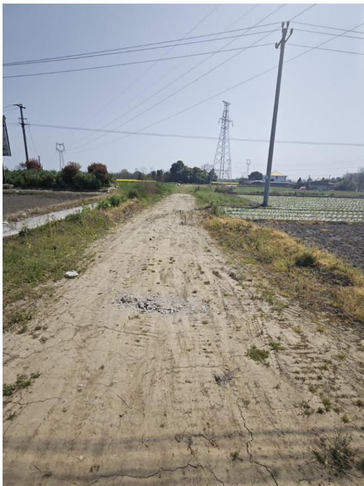
图 4.3-4 N26 施工道路，施工道路使用结束后未进行土地整治，恢复耕地
