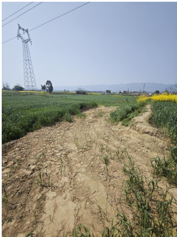
图 4.3-10 N70 施工道路，施工道路使用结束后未进行土地整治，恢复耕地
