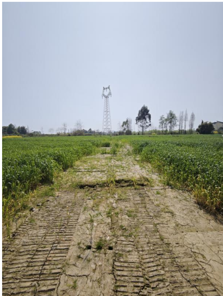
图 4.3-9 N66 施工道路，施工道路使用结束后未进行土地整治，恢复耕地
