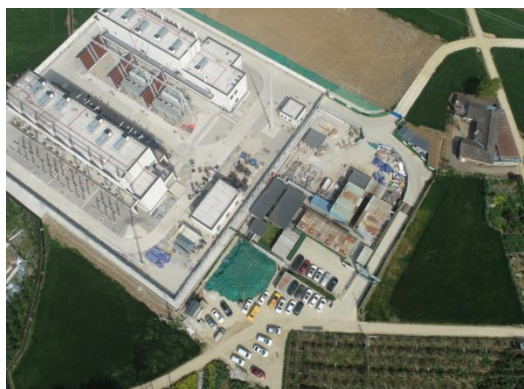
变电站主体工程区全景
