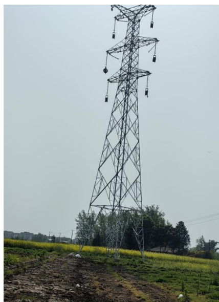
N104 塔位及施工道路
