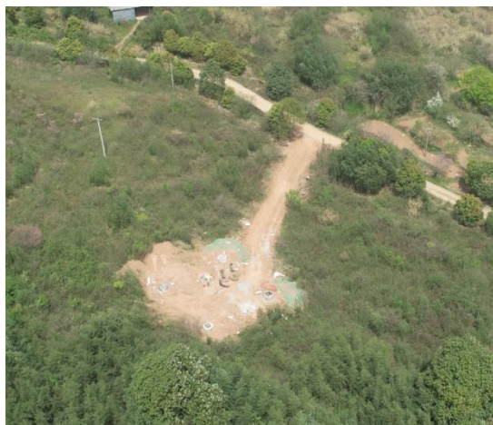
N27 塔位及施工道路
