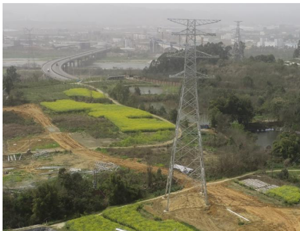
N7-N8 塔位及施工道路
