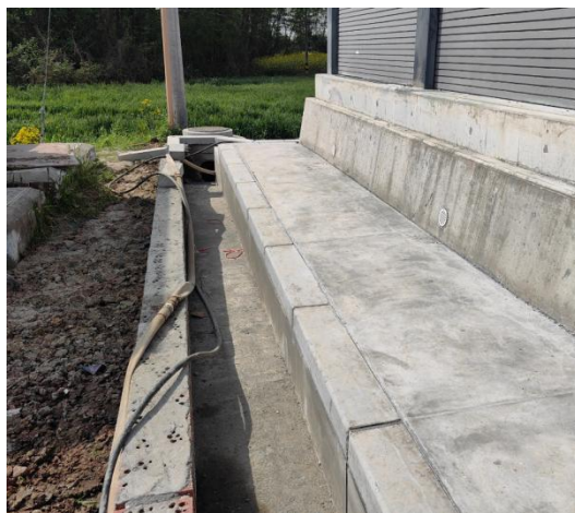
变电站主体工程区站外排水沟
