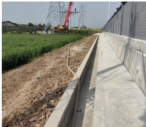
站外排水沟已砌筑完成（2024 年 4 季度、2025 年 1 季度对比图）
