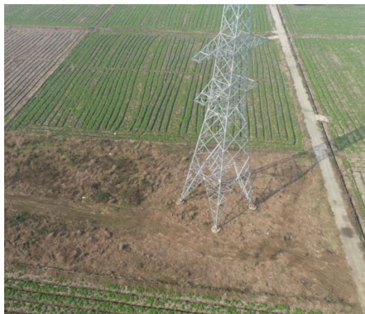
N61 塔位及施工道路
