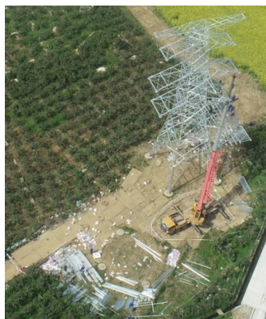
N105 塔位及施工道路
