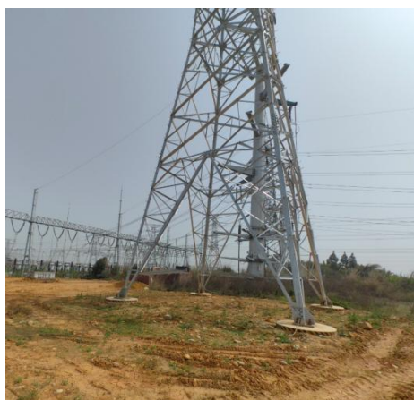
N1 塔位及施工道路
