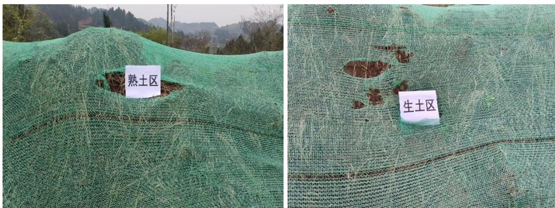
图8-13 图8-14塔基区表土分开堆存养护
