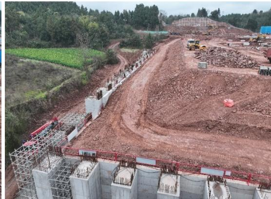
图5-5、图5-6 变电站缺少苫盖、垫付等水保措施
