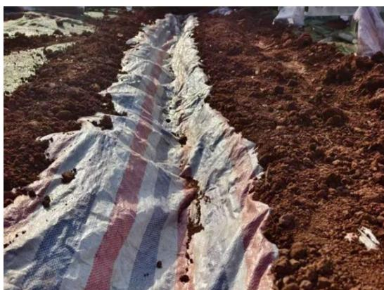
图8-9 塔基区临时堆土密目网苫盖
