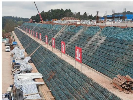
图8-4 变电站站区植生带护坡
