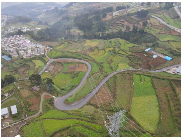
工程沿线现状（普格段）
