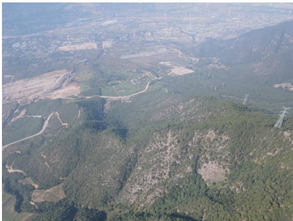
工程沿线现状（德昌段）
