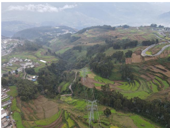
工程沿线现状（普格段）
