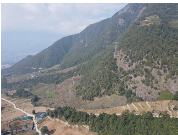
工程沿线现状（德昌段）
