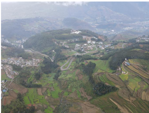
工程沿线现状（普格段）
