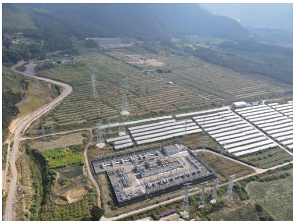
工程沿线现状（德昌段）
