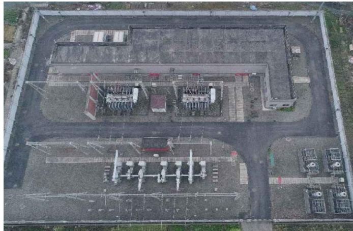
图 2.1-1 同善桥 110kV 变电站现状
