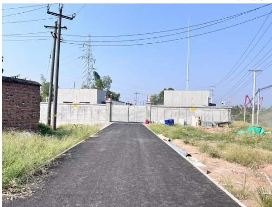
进站道路现状
