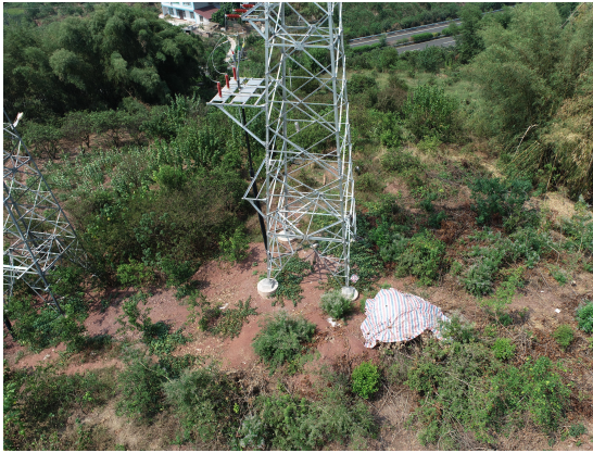
1号塔基牵张场场地恢复现状
