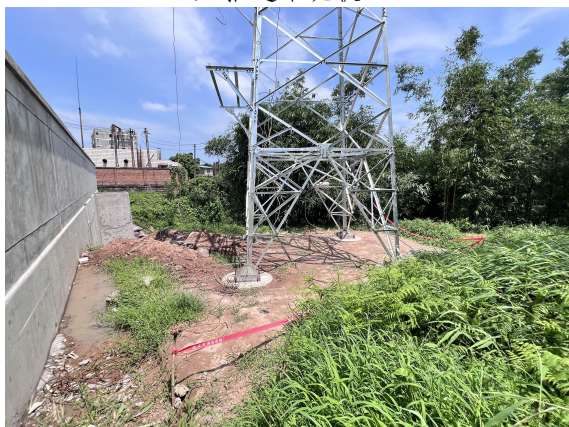
电缆沟施工过程中
