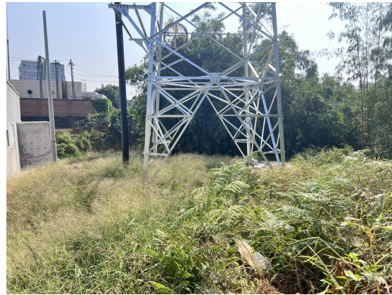
36号塔基牵张场场地恢复现状
