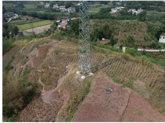
16号塔基牵张场场地恢复现状
