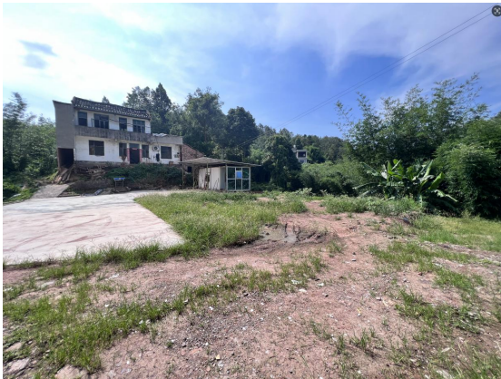
26号塔基牵张场场地恢复现状
