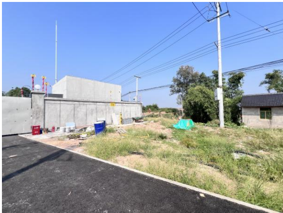
施工场地现状
