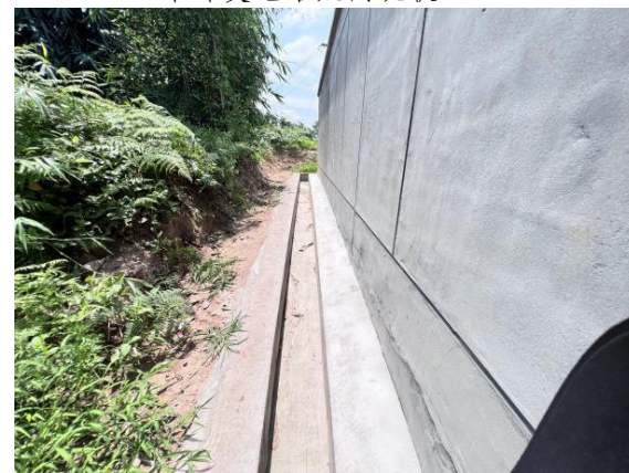
站外排水沟现状
