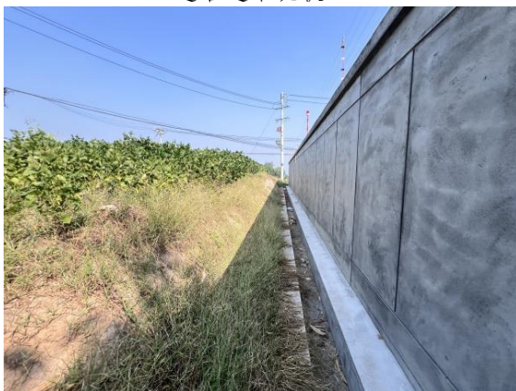
站外排水沟现状
