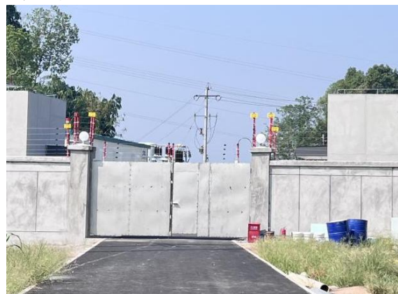
牟坪变电站大门现状
