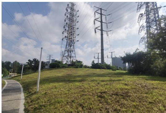
绕城段电缆施工场地（含施工道路）现状
