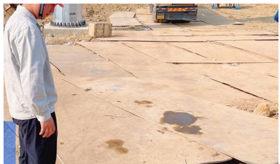
施工道路铺设钢板
