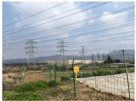
桃乡段电缆施工场地现状
