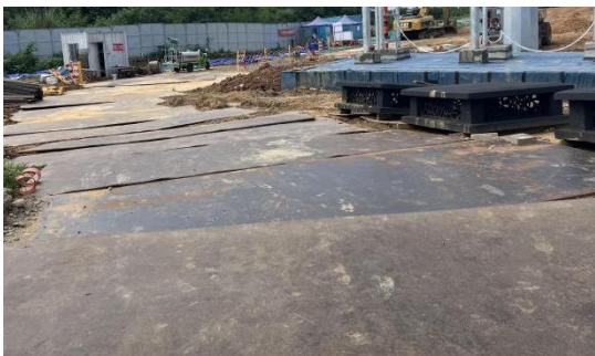
施工道路铺设钢板
