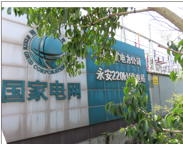
永安 220kV 变电站
