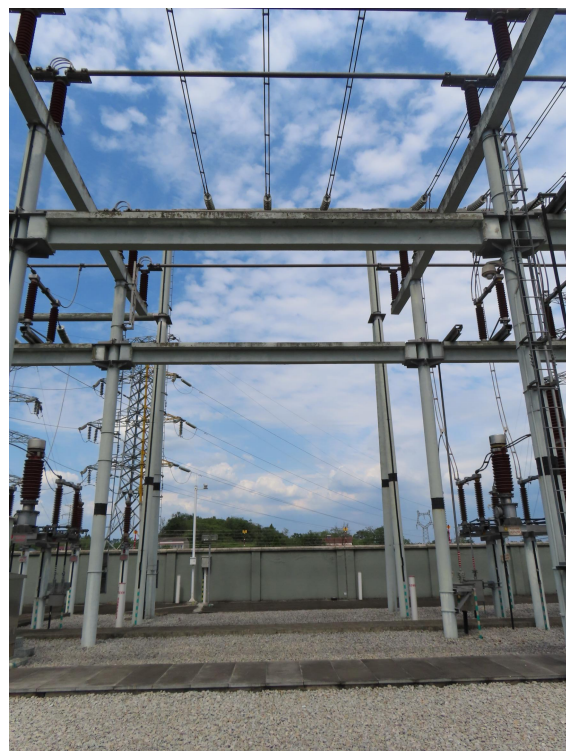
永安 220kV 变电站-1 号主变 110kV 进线配电装置预留场区
