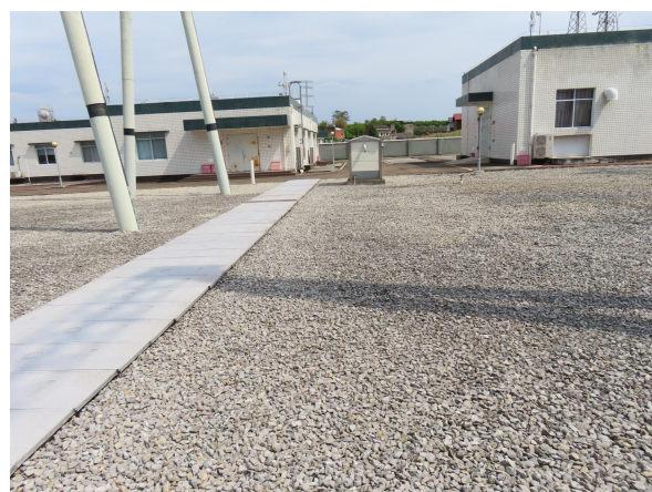
永安 220kV 变电站-碎石地坪
