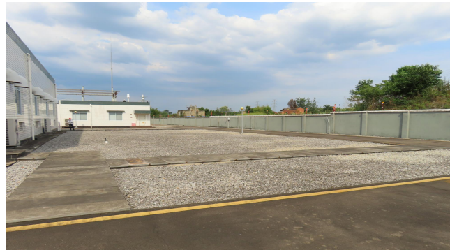
永安 220kV 变电站-1 号主变 35kV 电容器组预留场区
