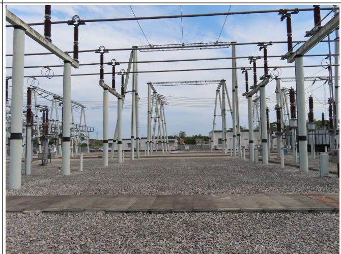
永安 220kV 变电站-1 号主变 220kV 进线配电装置预留场区
