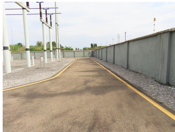
永安 220kV 变电站-站内道路
