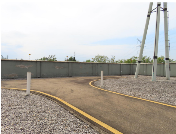
永安 220kV 变电站-站内道路
