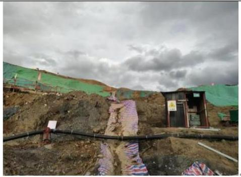
根据水土保持方案要求，增加临时排水沟，并以塑料布衬砌，排入自然冲沟。
