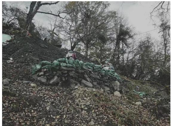
整改后：6、2L046 塔基区已进行表土剥离；拦挡措施已整改。
