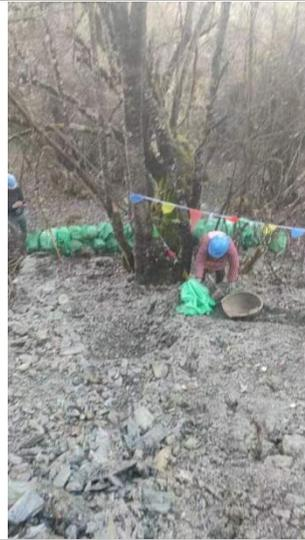
整改前：3、2R031 塔基区未进行表土剥离；无拦挡措施； 索道口施工材料下方无铺垫措施。
