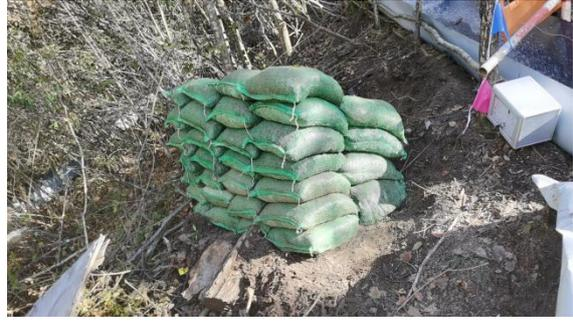
整改后：5、2R034 塔基区已进行表土剥离；拦挡措施已整改。
