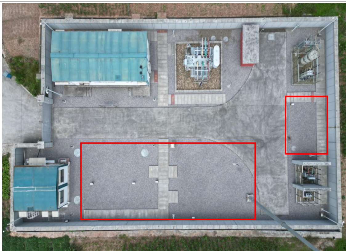
义路 35kV 变电站现状航拍图（红色区域为扩建内容）
