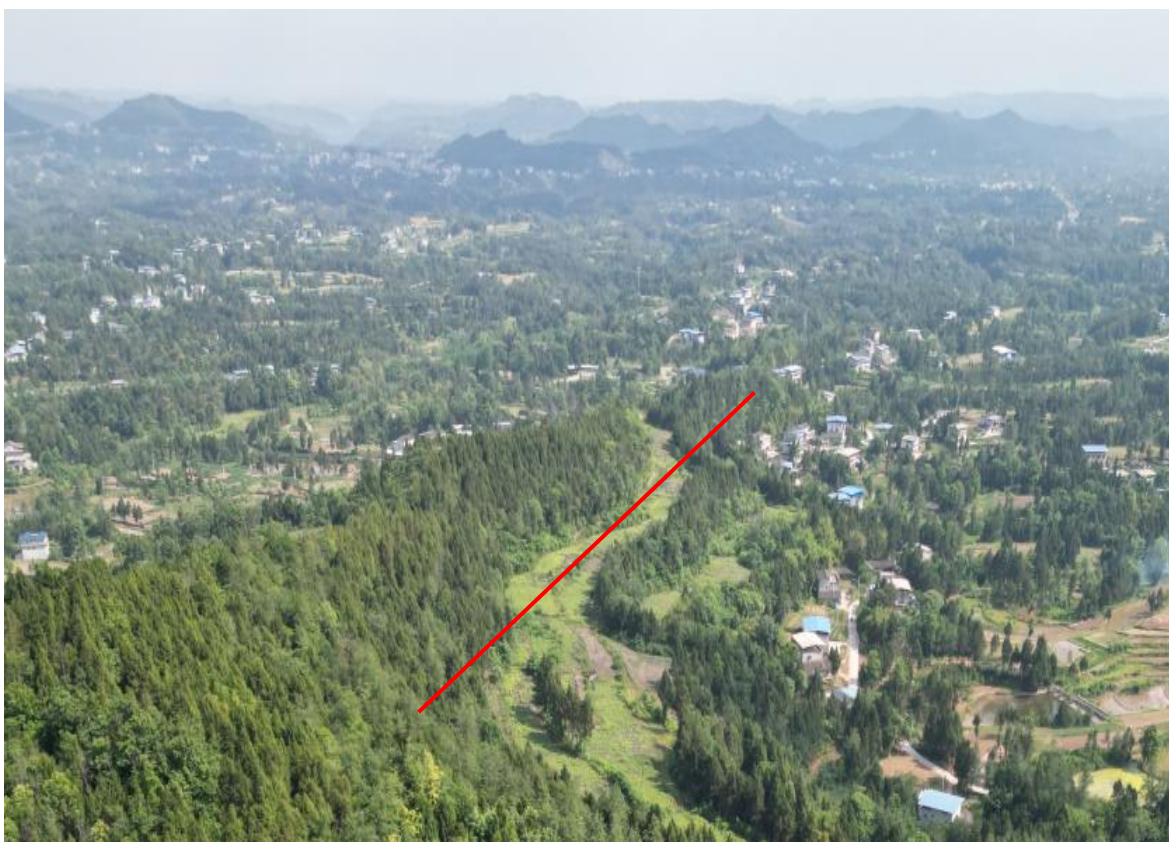
柳埡-义路 35kV 线路工程沿线照片
