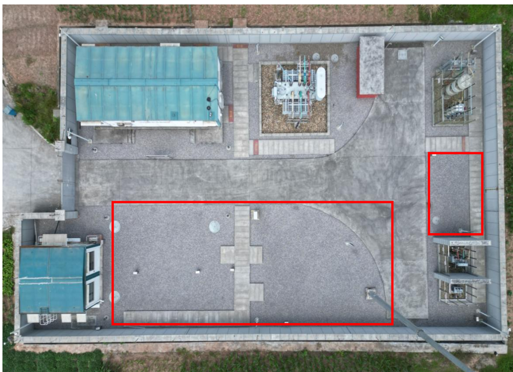
图 2-2 义路 35kV 变电站现状照片
