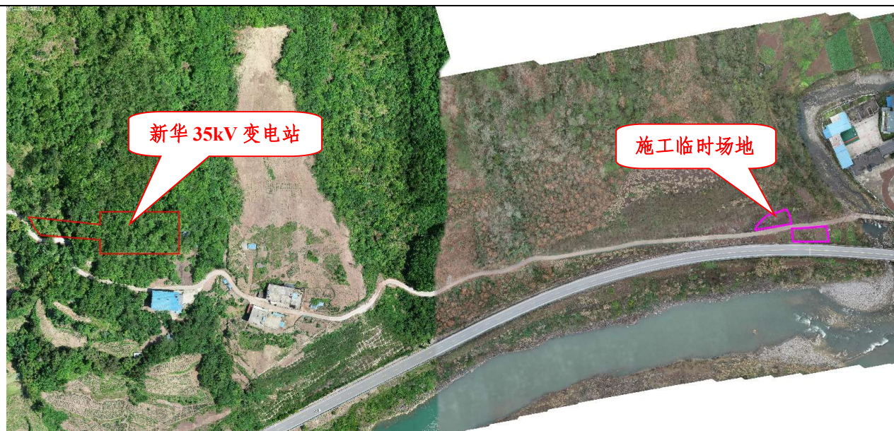
新华 35kV 变电站施工临时场地现状
