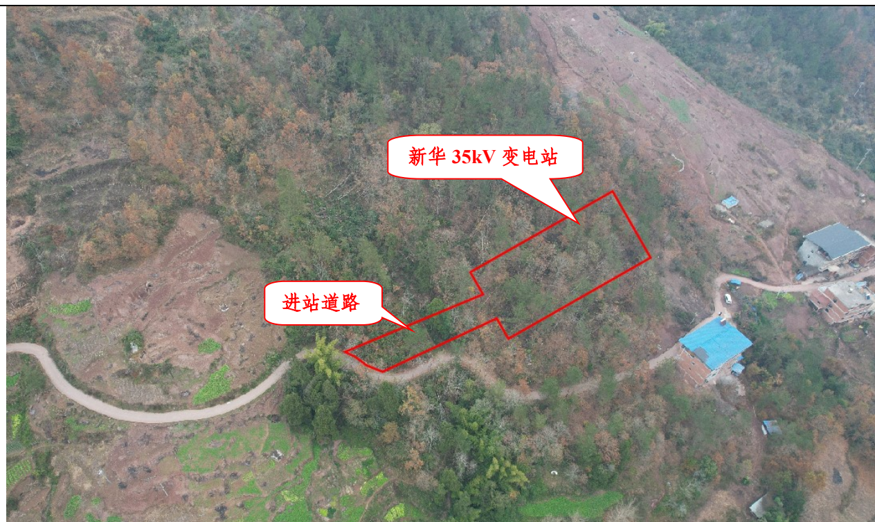
新华 35kV 变电站现状
