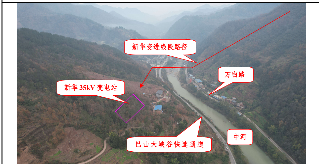
新华 35kV 变电站进线段地形地貌（跨万白路、中河、巴山大峡谷快速通道）
