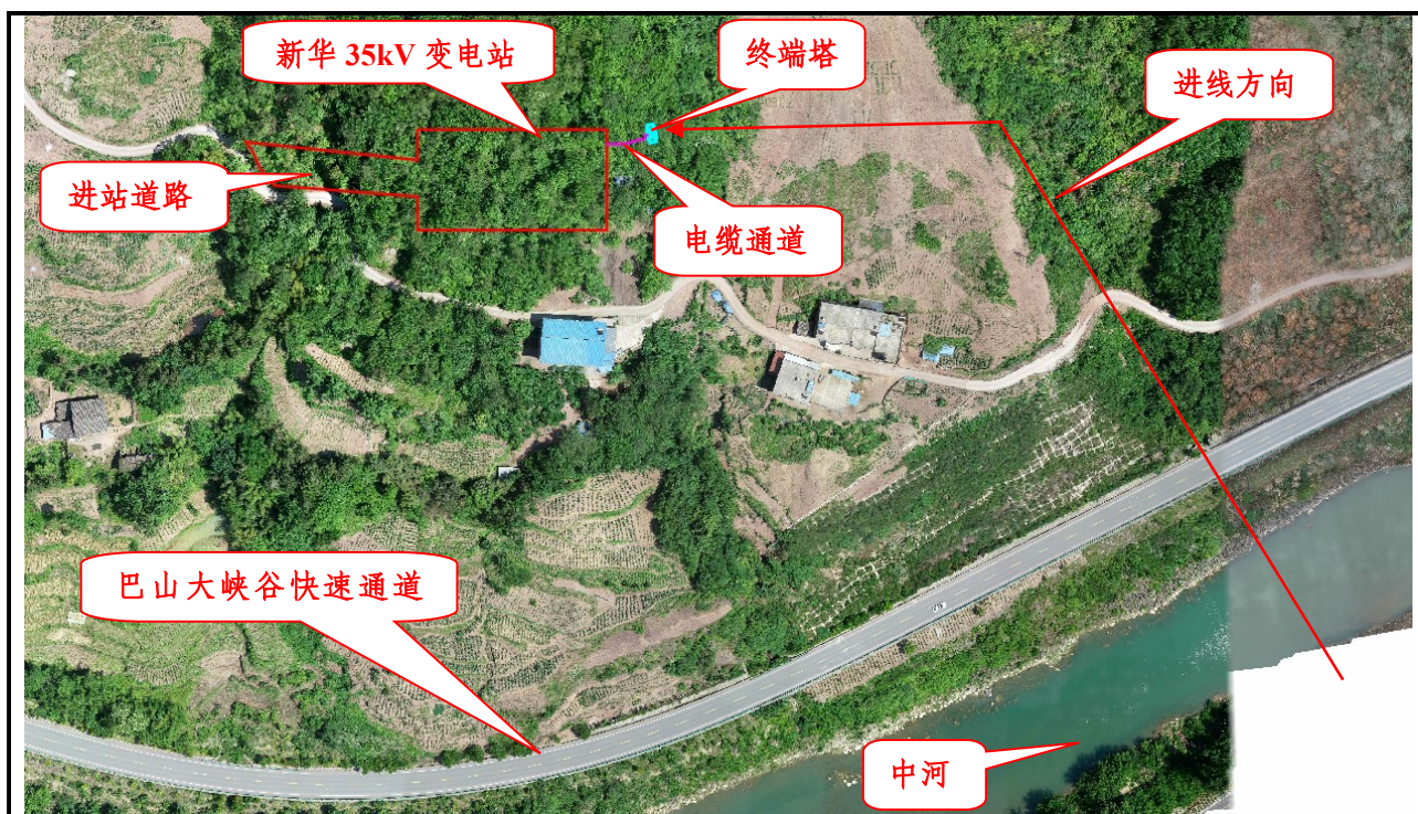
新华 35kV 变电站及进线现状
