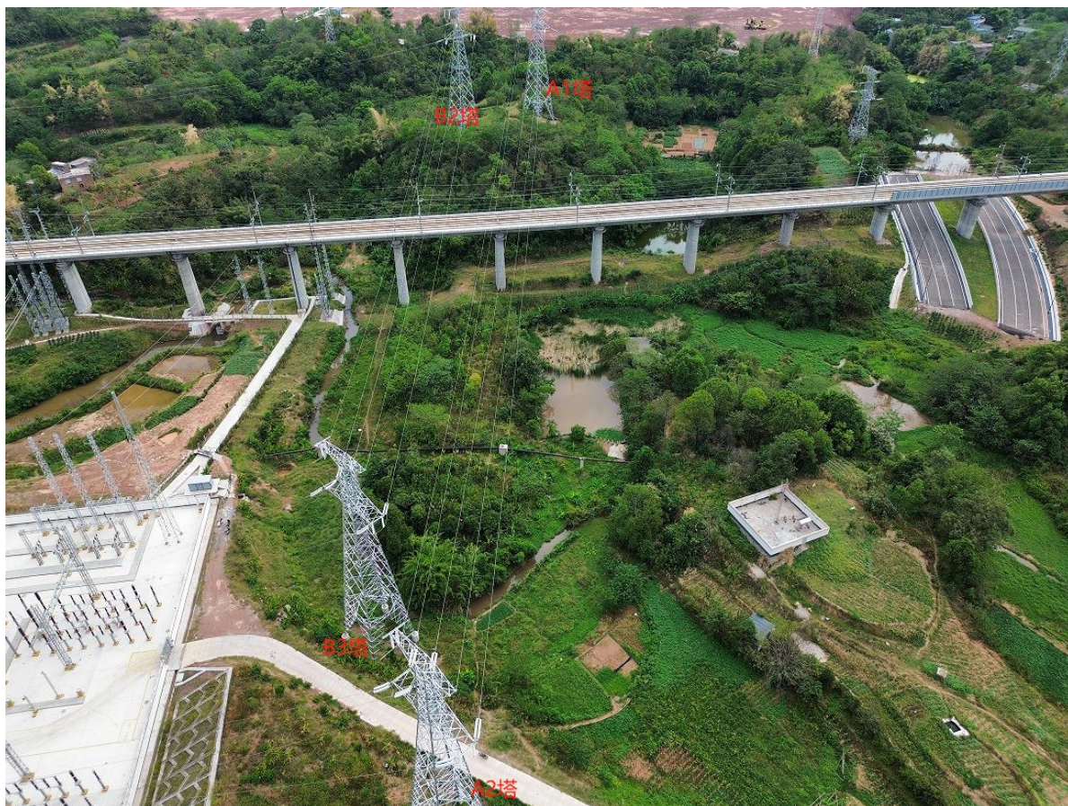
项目线路及塔基周围航拍现状
