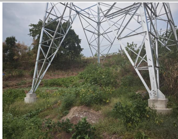
A2 塔塔基周围现状
