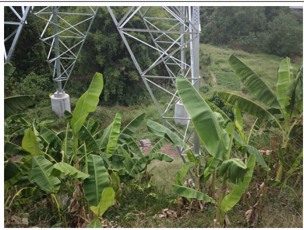
A3 塔塔基周围现状
