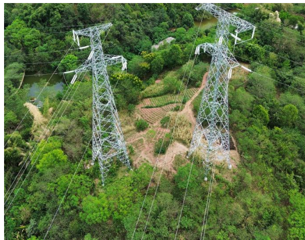
A1 和 B2 塔周围航拍现状
