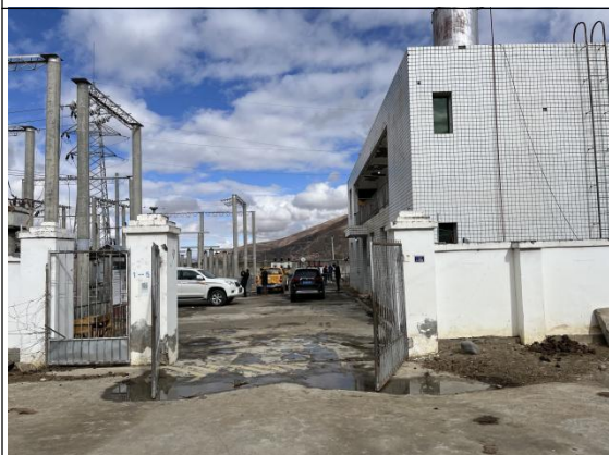
仁达35kV变电站现状
