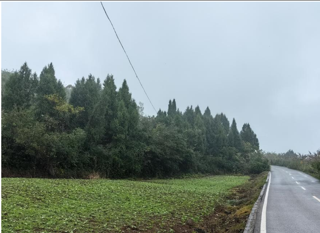
赤城-鸣凤 35kV 线路改造工程终点--接入本期新建鸣凤变电站
