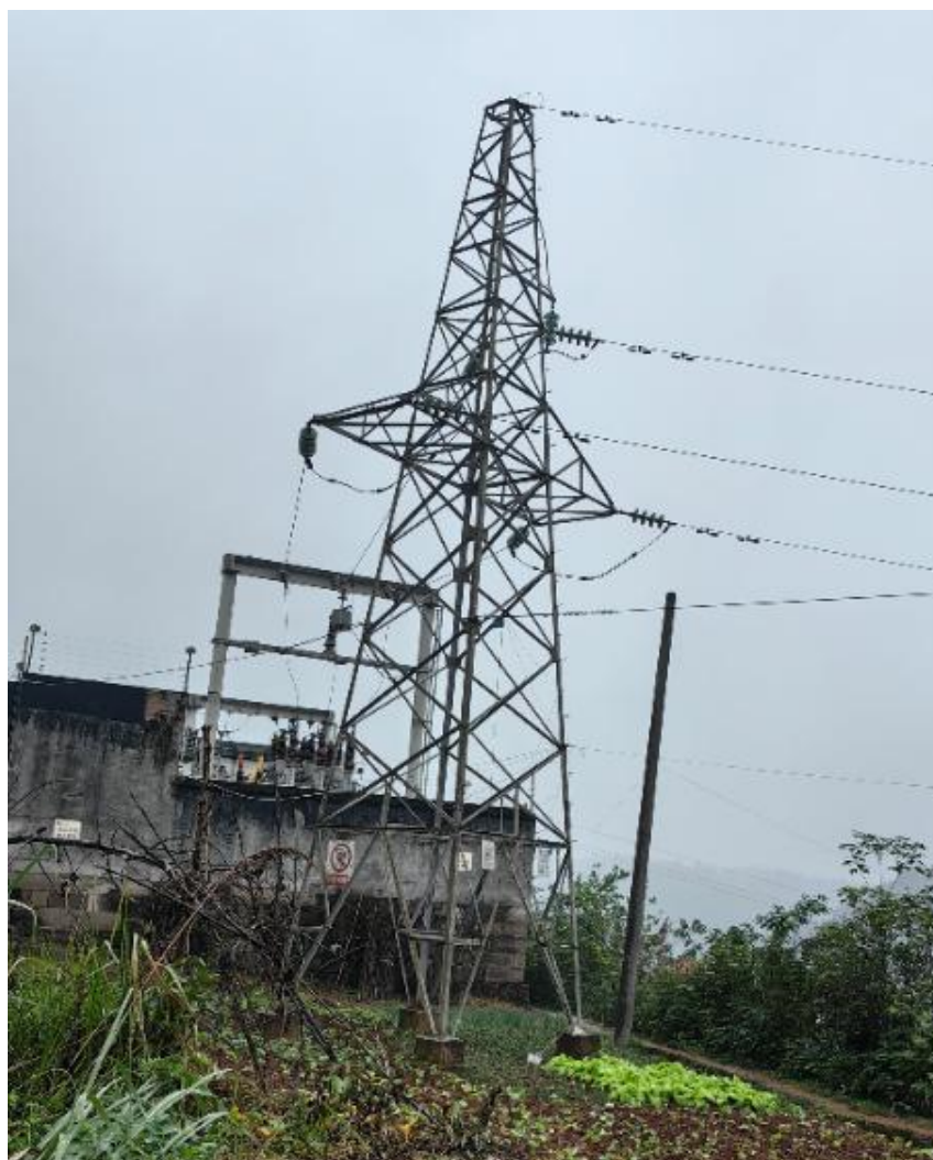
赤城-鸣凤 35kV 线路改造工程起点-35#塔
