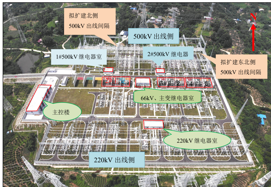
图 3-1 乐山南 500kV 变电站现状
