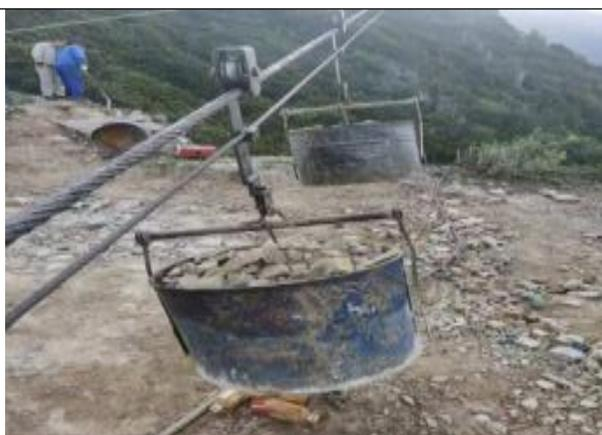
1L103正在进行余土外运，已进行临时拦挡，现场垃圾已清理。
