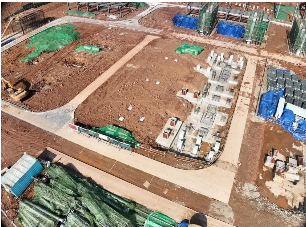
变电站施工现状
