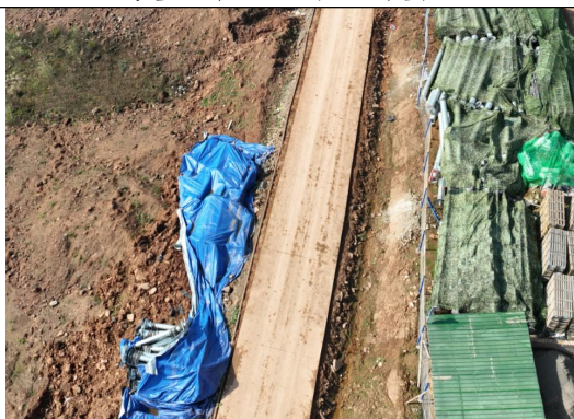
进场道路临时排水沟
