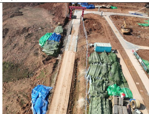
进站道路硬化
