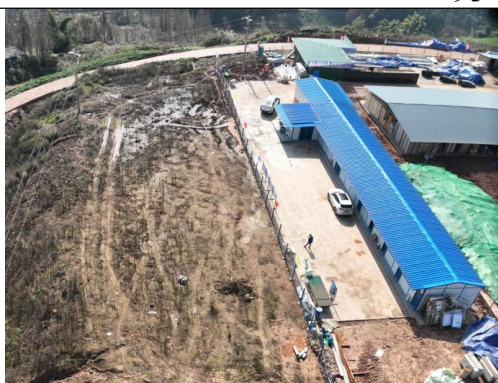
变电站施工驻地硬化
