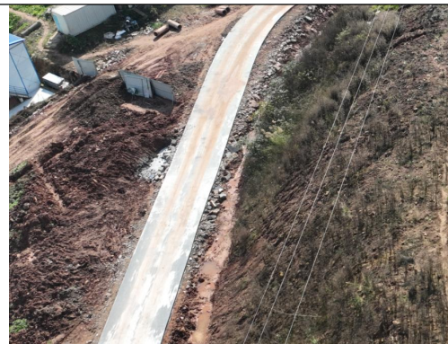
进场道路临时排水沟
