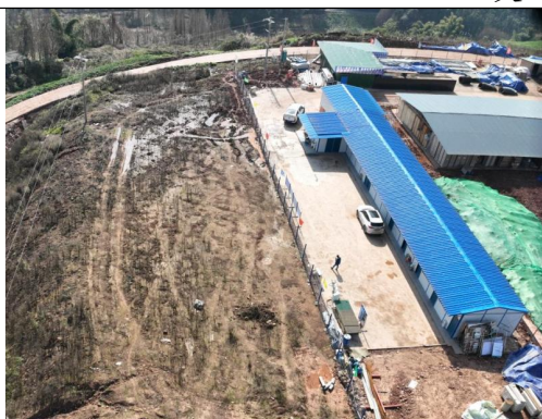
变电站施工驻地硬化
