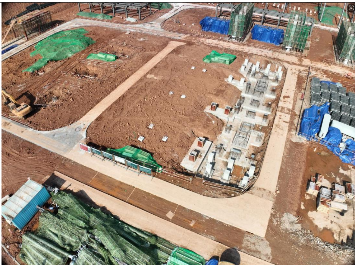
变电站施工现状
