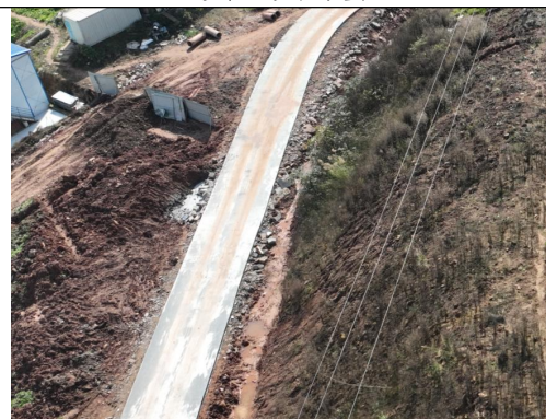
进场道路临时排水沟
