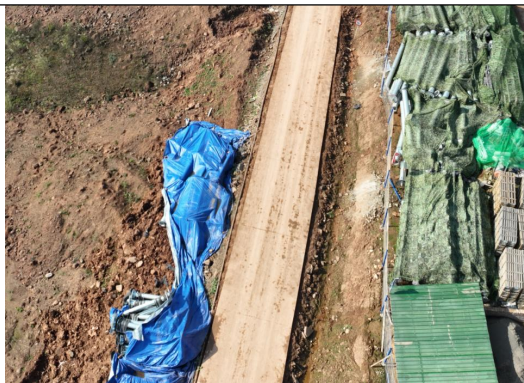
进场道路临时排水沟
