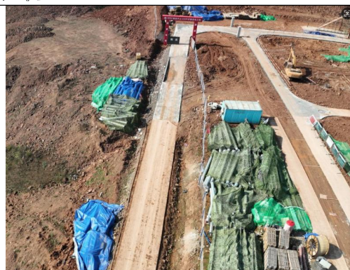
进站道路硬化
