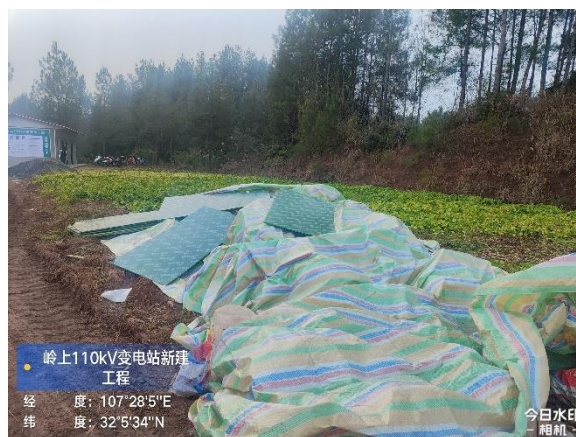
堆料临时苫盖
