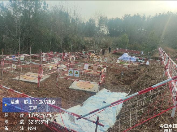
草池~岭上 N94 塔临时苫盖、铺垫
