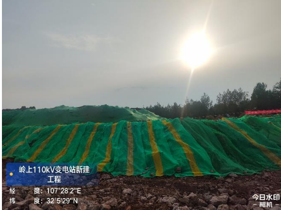
临时堆土苫盖
