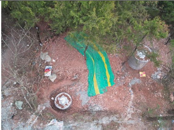
草池~岭上 N9 塔临时苫盖
