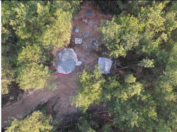
草池~岭上 N62 塔临时苫盖、铺垫
