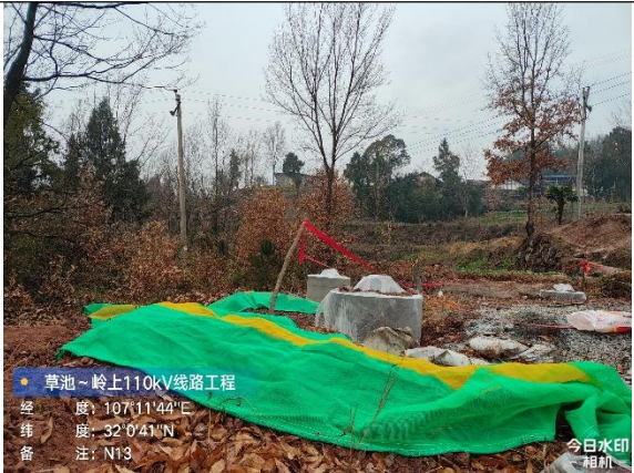
草池~岭上 N13 塔临时苫盖
