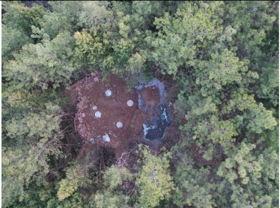
草池~岭上 N83 塔表土剥离、临时铺垫
