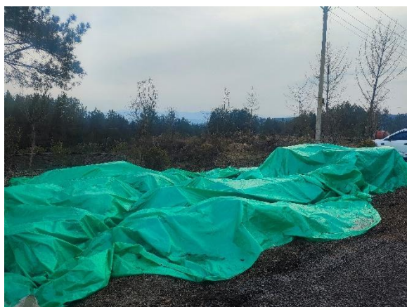
堆料临时苫盖
