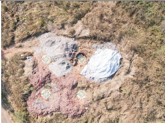
永安~岭上 N32 塔临时苫盖、铺垫
