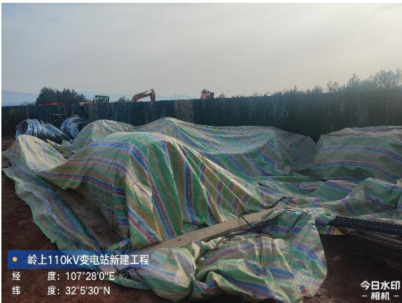
堆料临时苫盖
