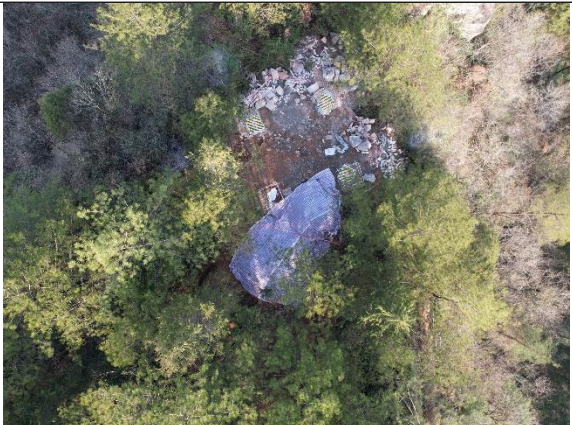
永安~岭上 N35 塔临时苫盖
