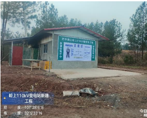
施工临时场地
