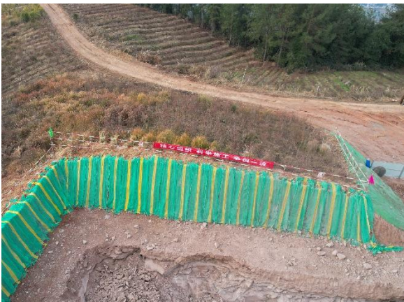
开挖坡面临时苫盖
