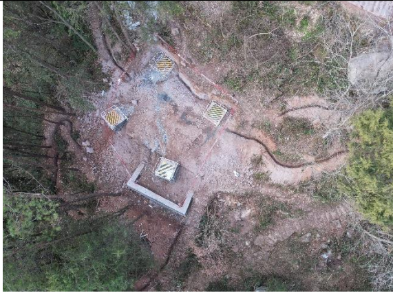
草池~岭上 N87 塔浆砌石挡墙
