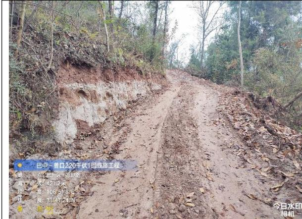
巴中~曾口 I 回 N7 塔新修汽运道路形成的坡面无临时防护, 临时排水、沉沙设施缺乏
