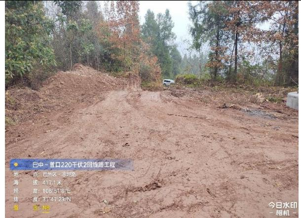
巴中~曾口 II 回 N8 塔新修汽运道路形成的坡面无临时防护, 临时排水、沉沙设施缺乏
