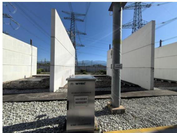
图片 4-2 变电站扩建区域现状
