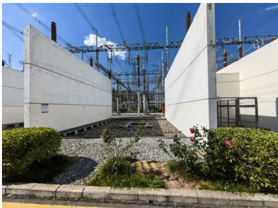
图片 4-1 变电站扩建区域现状
