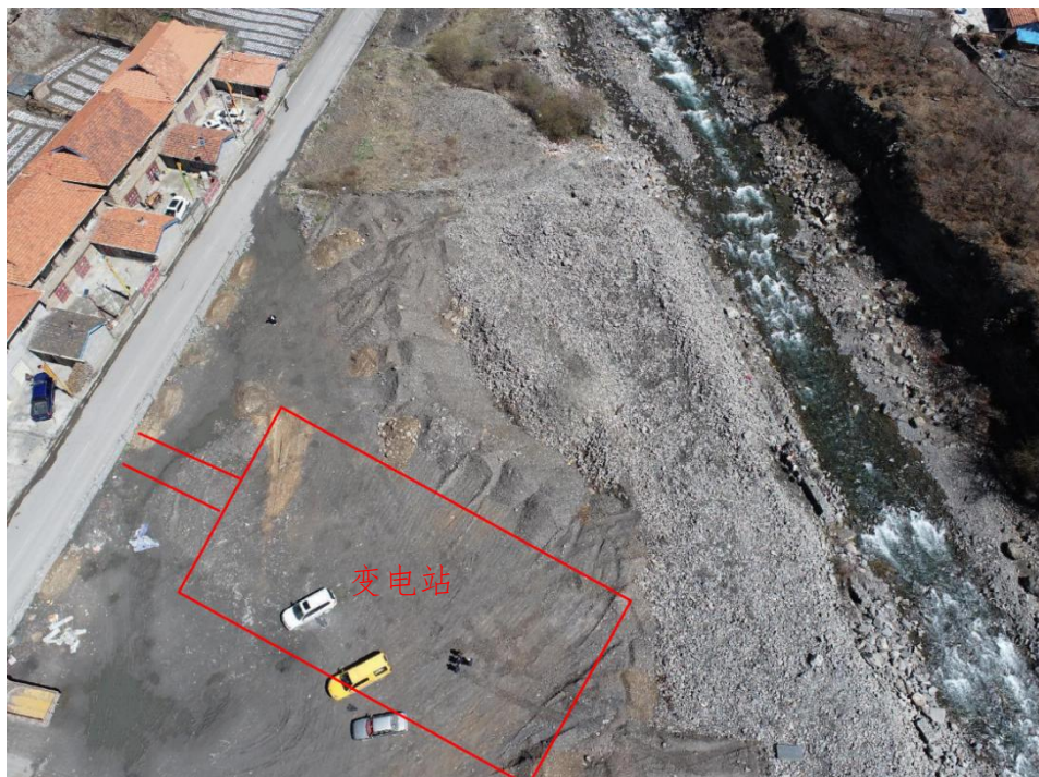
图 2-1 知木林 35kV 变电站现场情况图
