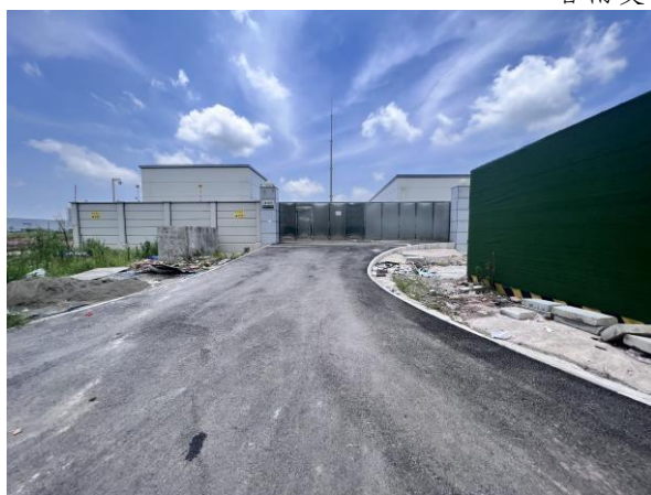
进站道路现状
