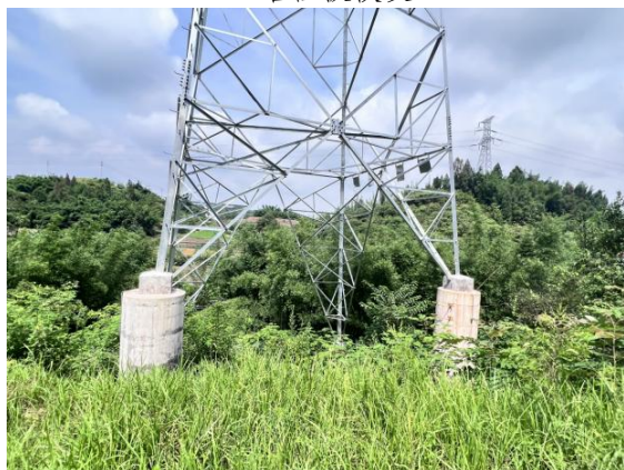
N19#塔植被恢复
