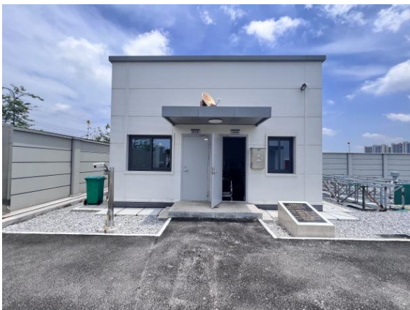
站内值班室现状
