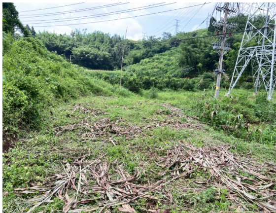
N21#塔基进场道路复耕
