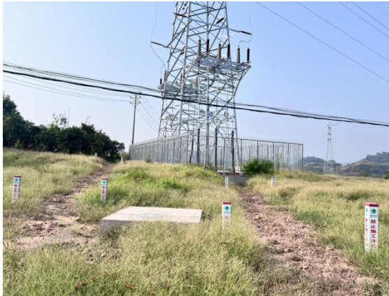
电缆沟植被恢复现状
