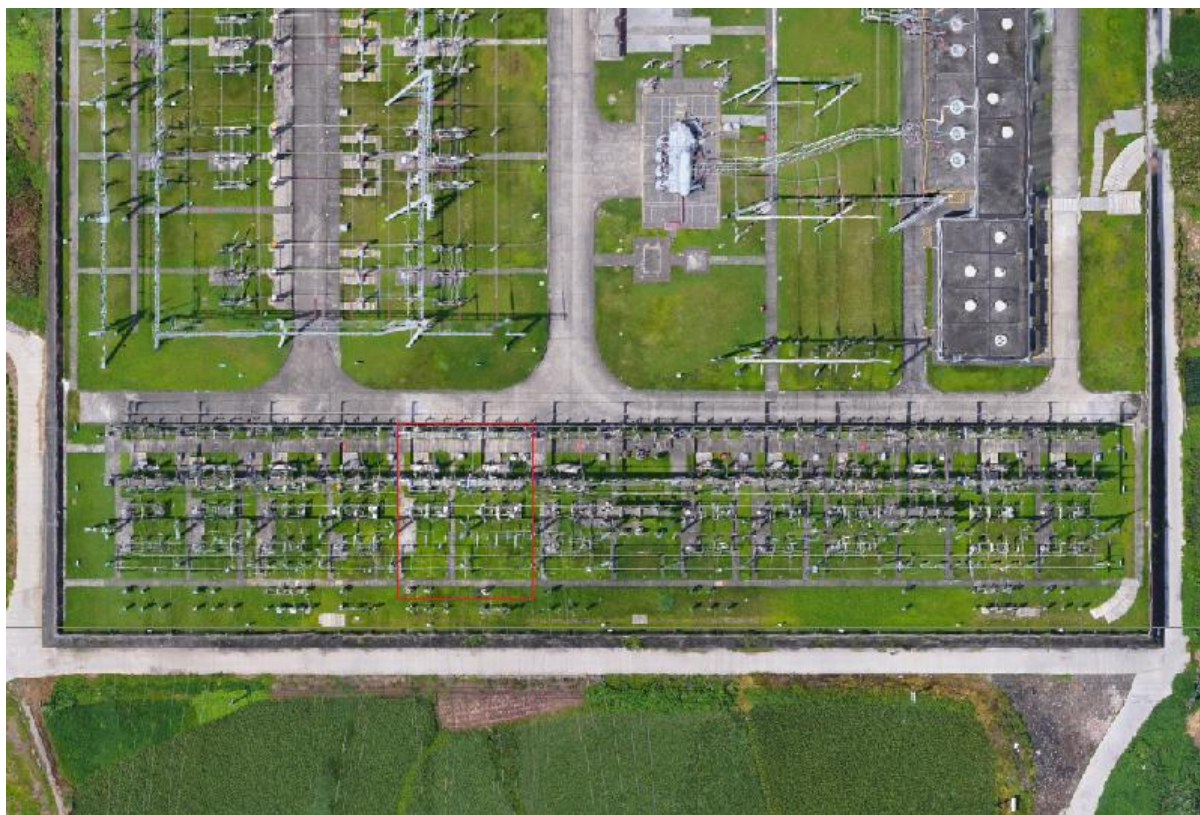
江南 220kV 变电站间隔扩建工程现状
