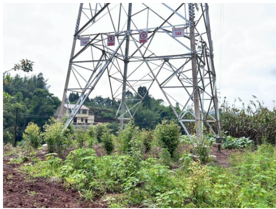
N13#塔植被恢复
