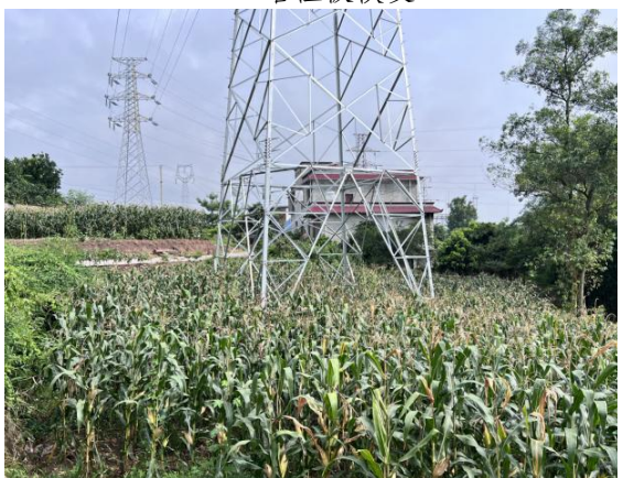
N3#塔植被恢复
