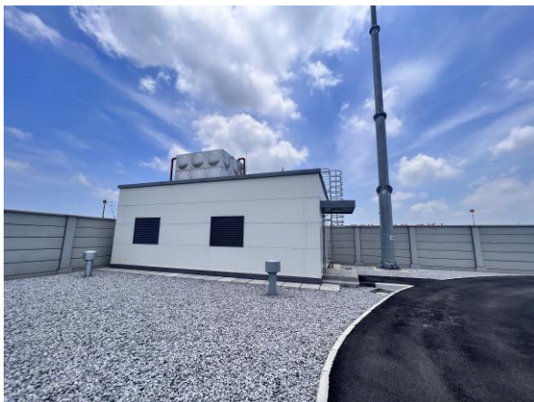
消防泵房现状
