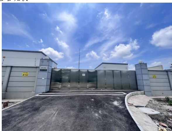
春雨变电站大门
