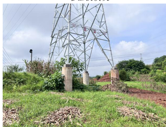
N7#塔植被恢复
