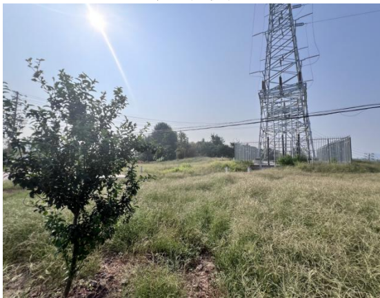
电缆沟植被恢复现状
