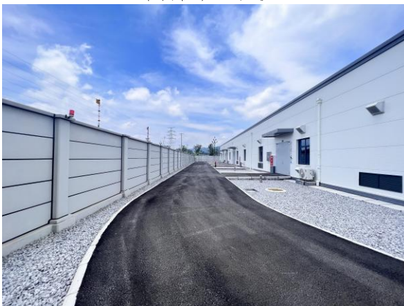
站内硬化道路现状
