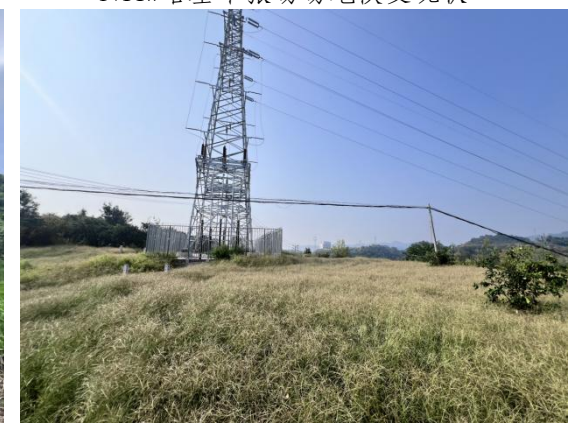
N30#塔基牵张场场地恢复现状
