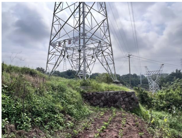
N4#塔基挡墙现状
