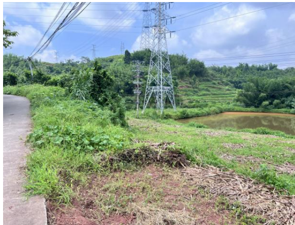
N21#塔基进场道路复耕
