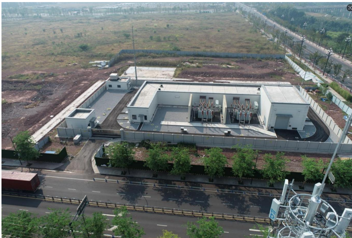
春雨变电站现状
