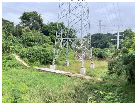
N6#塔植被恢复
