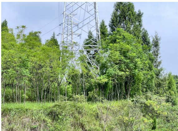
N12#塔植被恢复
