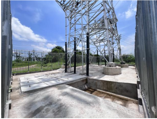
N30#塔基平台硬化
