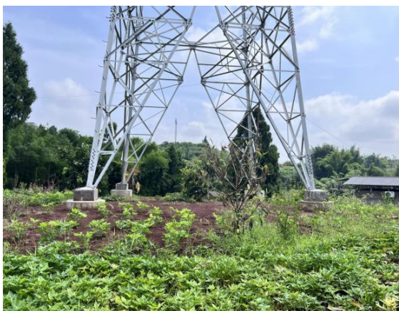
N14#塔植被恢复
