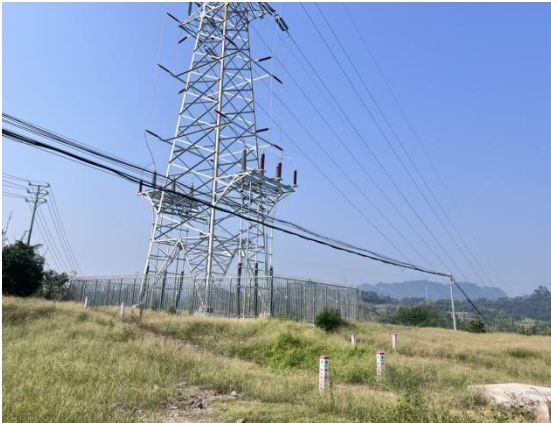
N30#塔植被恢复
