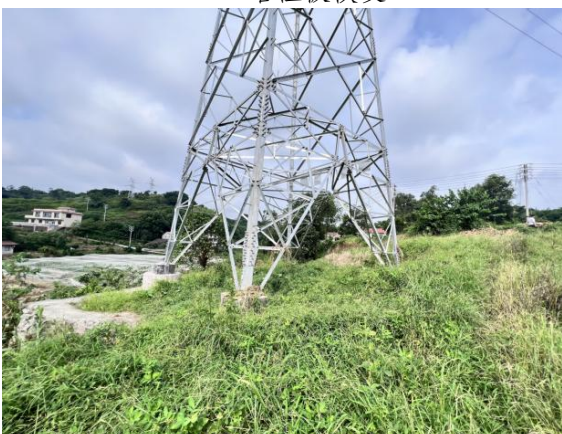
N4#塔植被恢复
