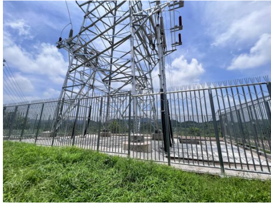
N30#塔植被恢复
