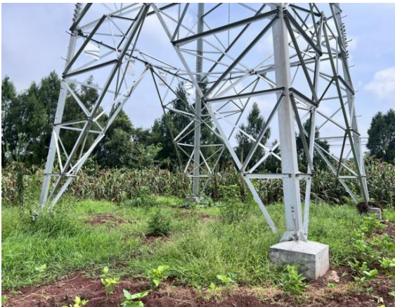
N15#塔植被恢复
