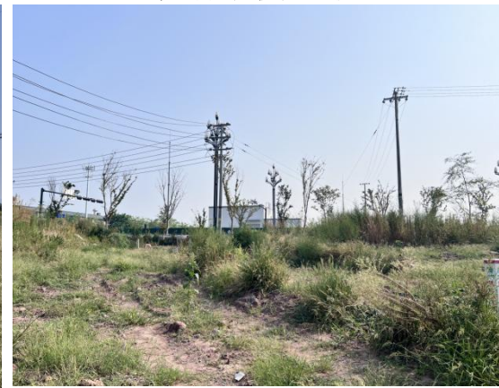
电缆沟植被恢复现状
