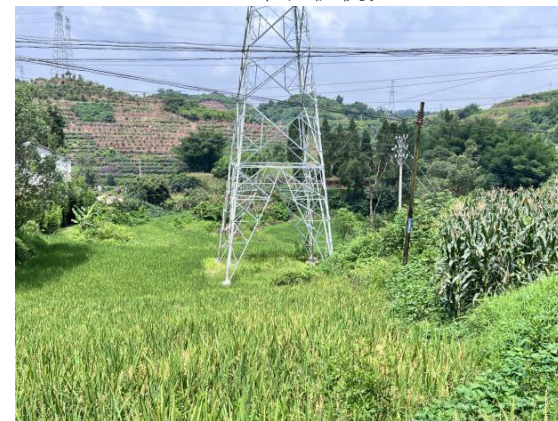
N23#塔植被恢复
