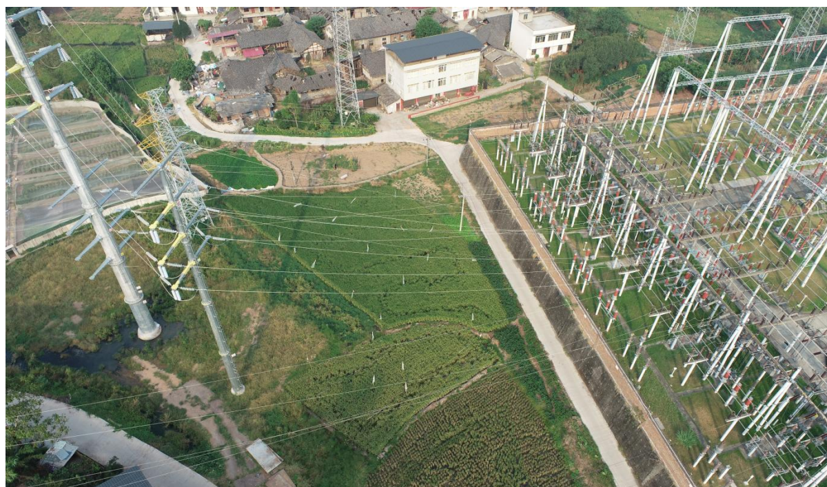
江南 220kV 变电站间隔扩建工程现状
