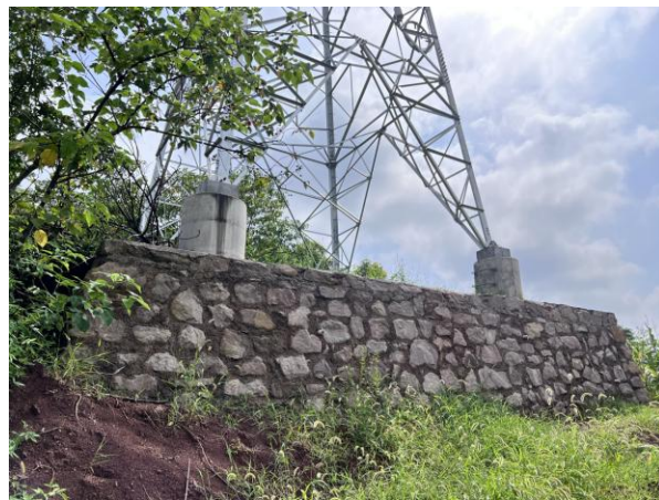
N11#塔基挡墙现状
