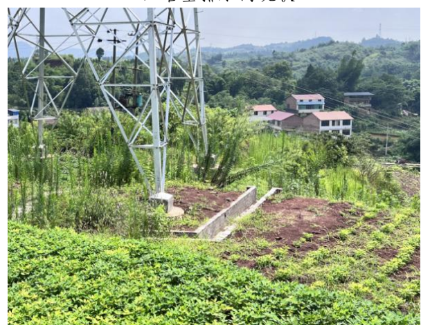
N17#塔基排水沟现状
