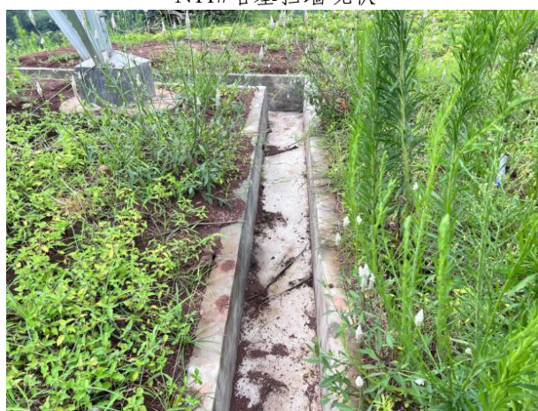
N17#塔基排水沟现状
