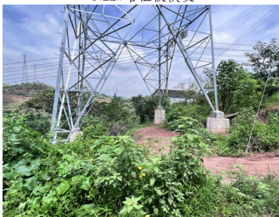
N24#塔植被恢复
