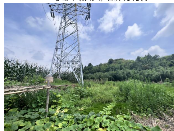
N20#塔基牵张场场地恢复现状
