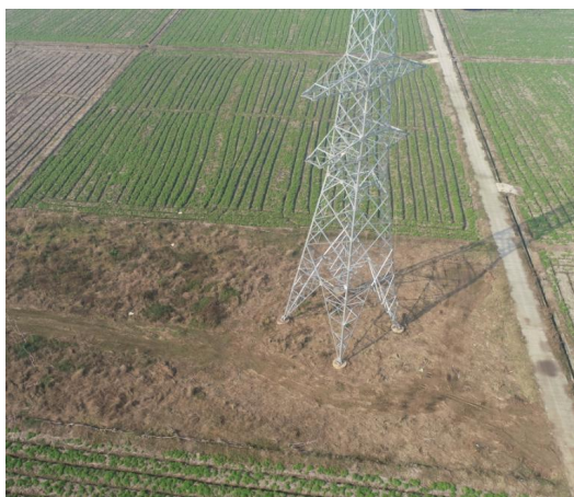
N61 塔位及施工道路
