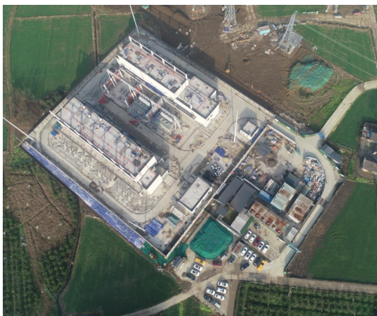
变电站主体工程区全景
