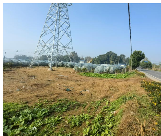
N42 塔位及施工道路
