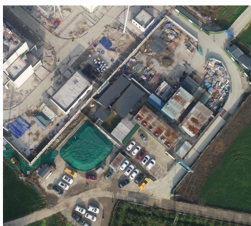
储能项目预留区场地硬化、临时遮盖
